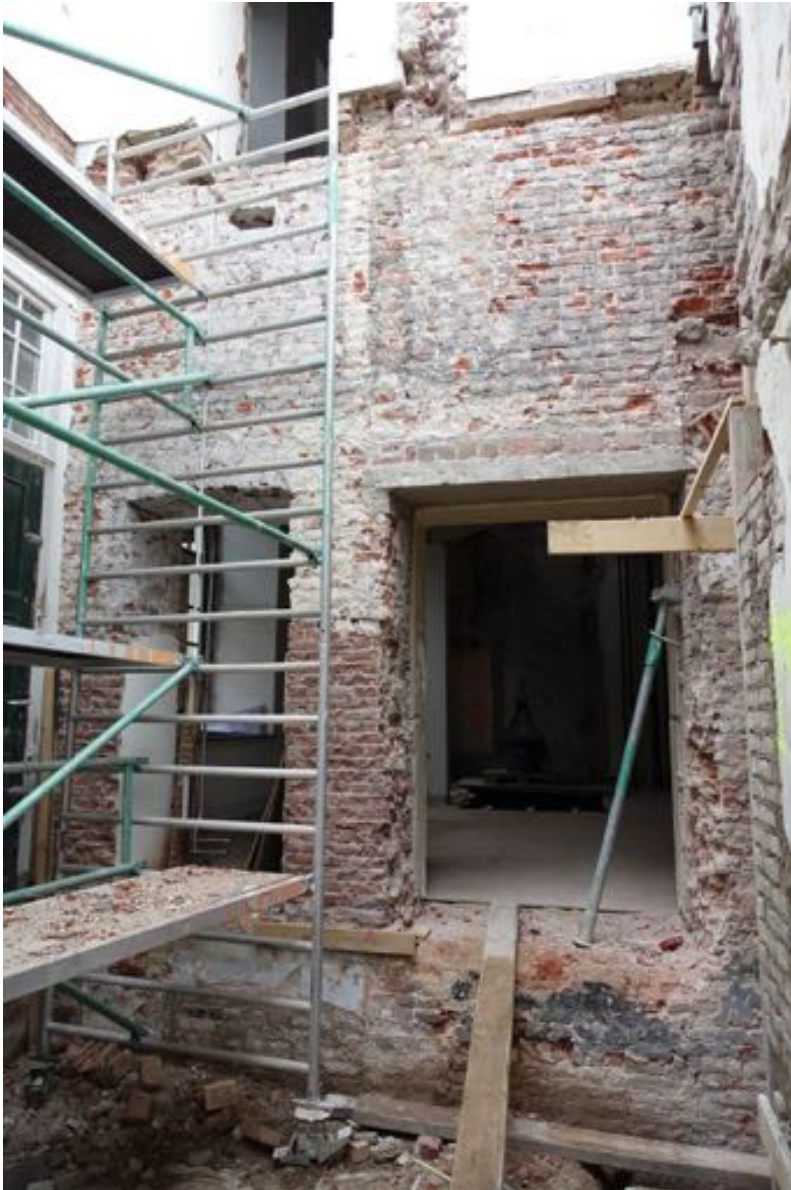
Linkerdeel van de achtergevel, met linksonder een dichtgemetseld kelderlicht. Boven de twee huidige openingen zijn dichtzettingen herkenbaar.
