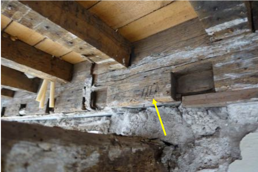
Detail gegutste telmerken, bij de pijl merk 'VIII'.
