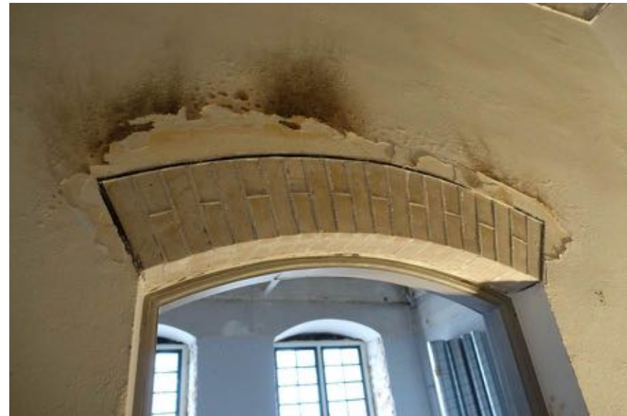
Detail gereinigde boog boven deuropening.
