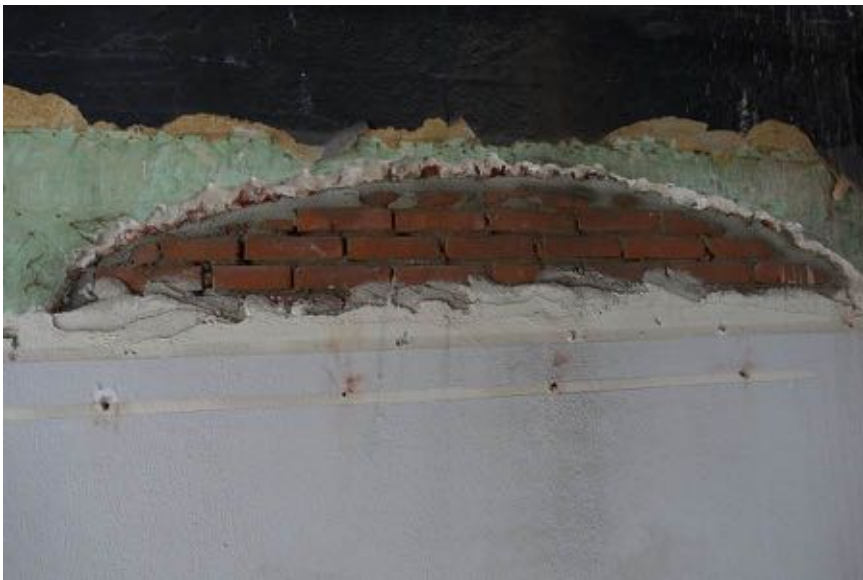
Detail van de met recente machinale baksteen dichtgemetselde boog.
