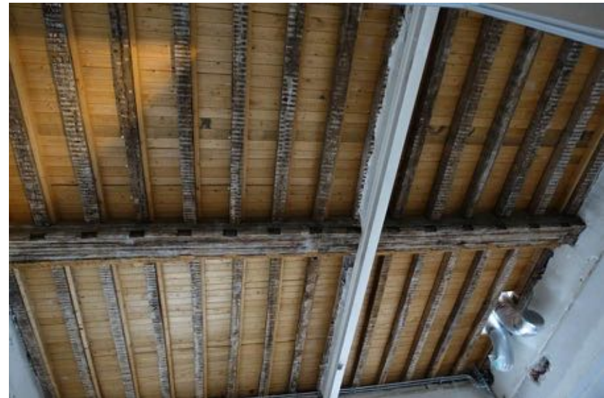
Overzicht samengestelde balklaag boven ruimte 05, gezien richting de linker zijgevel.
