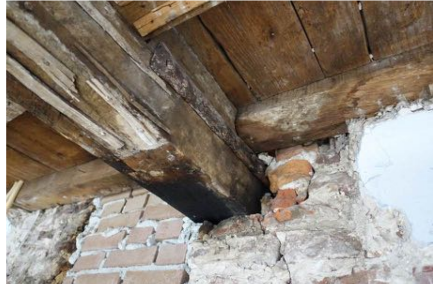
Aftekening van een schouw bij de aansluiting van de moerbalk op de voorwand van ruimte 06 (zie ook par. 2.2.2).
