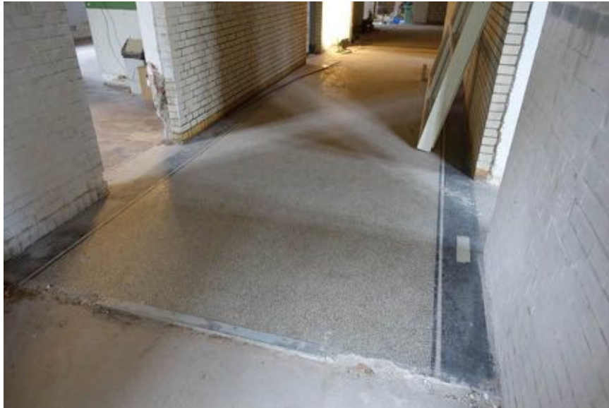
Granitovloer op steenachtige ondergrond in de middengang (07).
