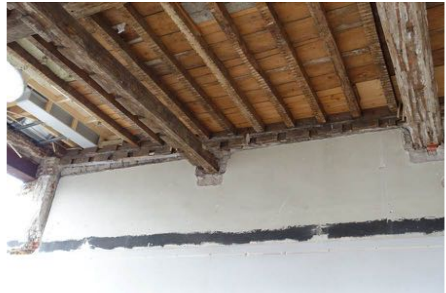
Boven de wand tussen 05 en 06 herplaatste moerbalk, met aan de zijde van 06 gegutste telmerken III t/m XV.
