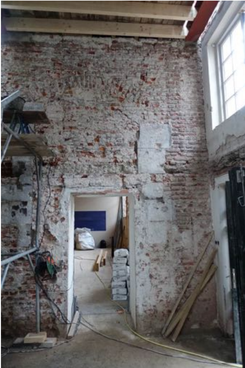
Rechterzijde oorspronkelijke achtergevel, met hier aan de segmentboog en natuurstenen dagkanten herkenbare oorspronkelijke gevelopening.
