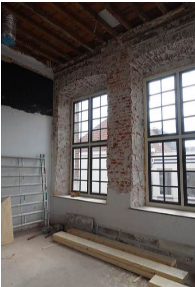
Overzicht linker twee vensters in ruimte 06 op de verdieping. De huidige getoogde bovenzijde van de vensters werd in 1912 in machinale baksteen uitgevoerd.
