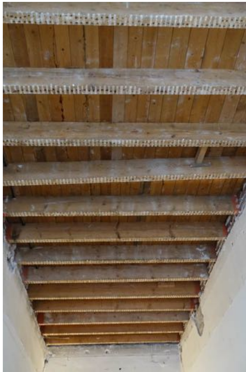
Enkelvoudige balklaag boven de middengang (07), richting achtergevel.
