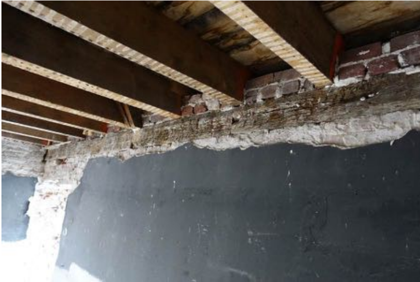
Beeld van het ruw behakte oppervlak van de balk. Dit om stucwerk beter te laten hechten.
