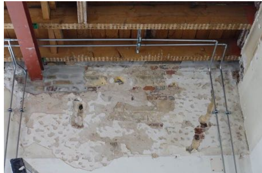
Overzicht van het in de voorwand van ruimte o8 zichtbare muurveld met een afwisseling van baksteen en mergel.
