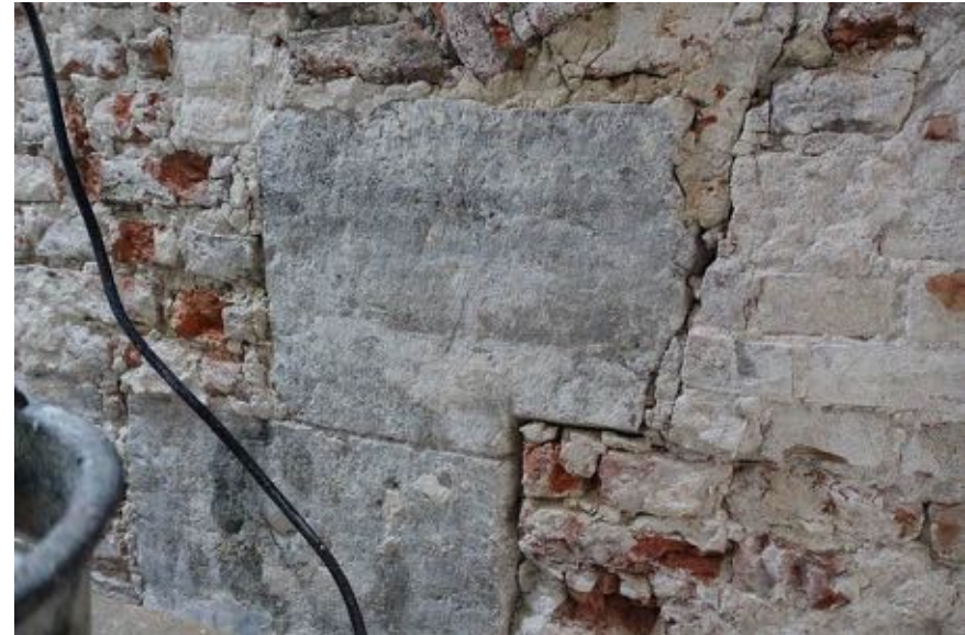
Detail linkerbovenhoek oorspronkelijke opening.
