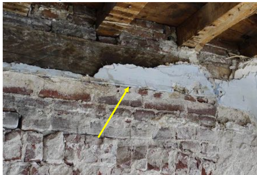
Venster linker zijgevel (ruimte 06) waar boven het metselwerk uit 1912 het pleisterwerk van de bovenrand van de eerdere vensteropening bewaard bleef (pijl).
