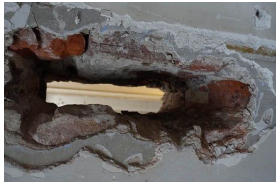
In de doorbraak van de muur zijn de oudere bakstenen herkenbaar.
