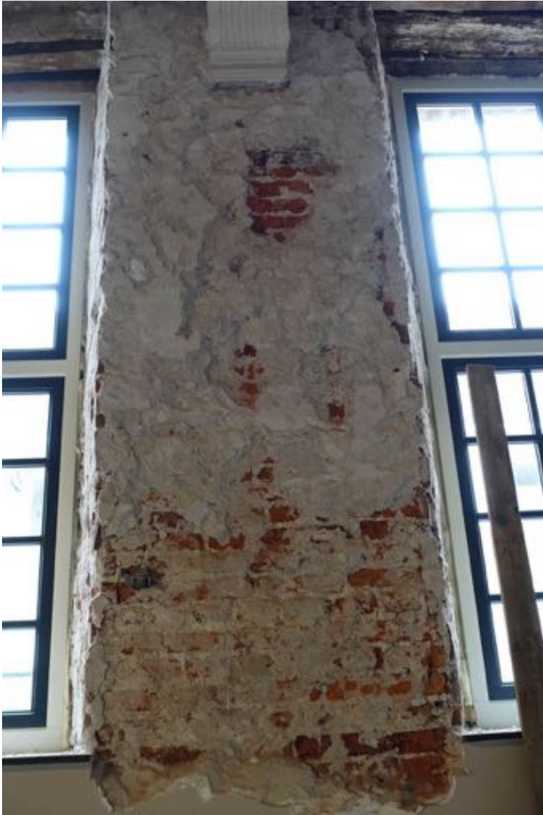
Detail muurdam tussen vensters, met grotendeels oorspronkelijk metselwerk.
