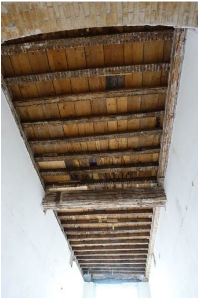
Overzicht balklaag boven de gang (05) richting achtergevel.
