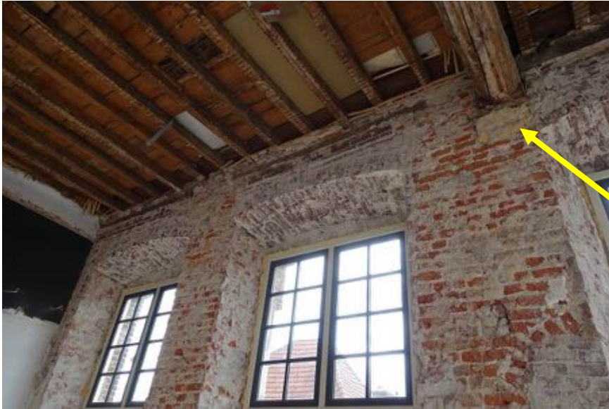
Detail bovenzijde linker twee vensters. Rechts is ook de oplegging van de nog aanwezige grenen onderslag zichtbaar (pijl).
