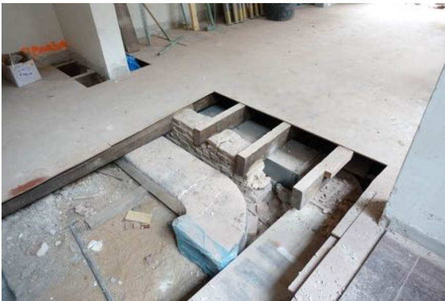
Zicht op de enkelvoudige balklaag van de ruimtes 01 en 02.
