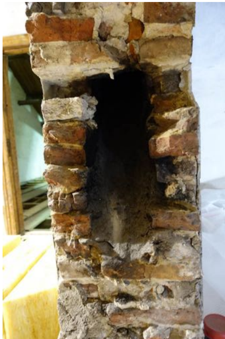
Zicht in het in de anderhalfsteens muur uitgespaarde rookkanaal.
