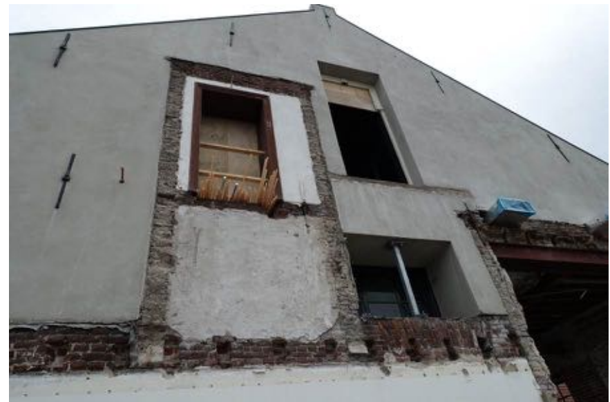
Bovenste deel van de achtergevel, waar ter plaatse van de linker aansluiting van het eerdere trapportaal een wat groter baksteenformaat herkenbaar lijkt.
