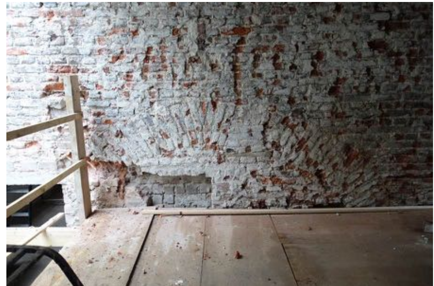
Overzicht van de samengestelde boog.
