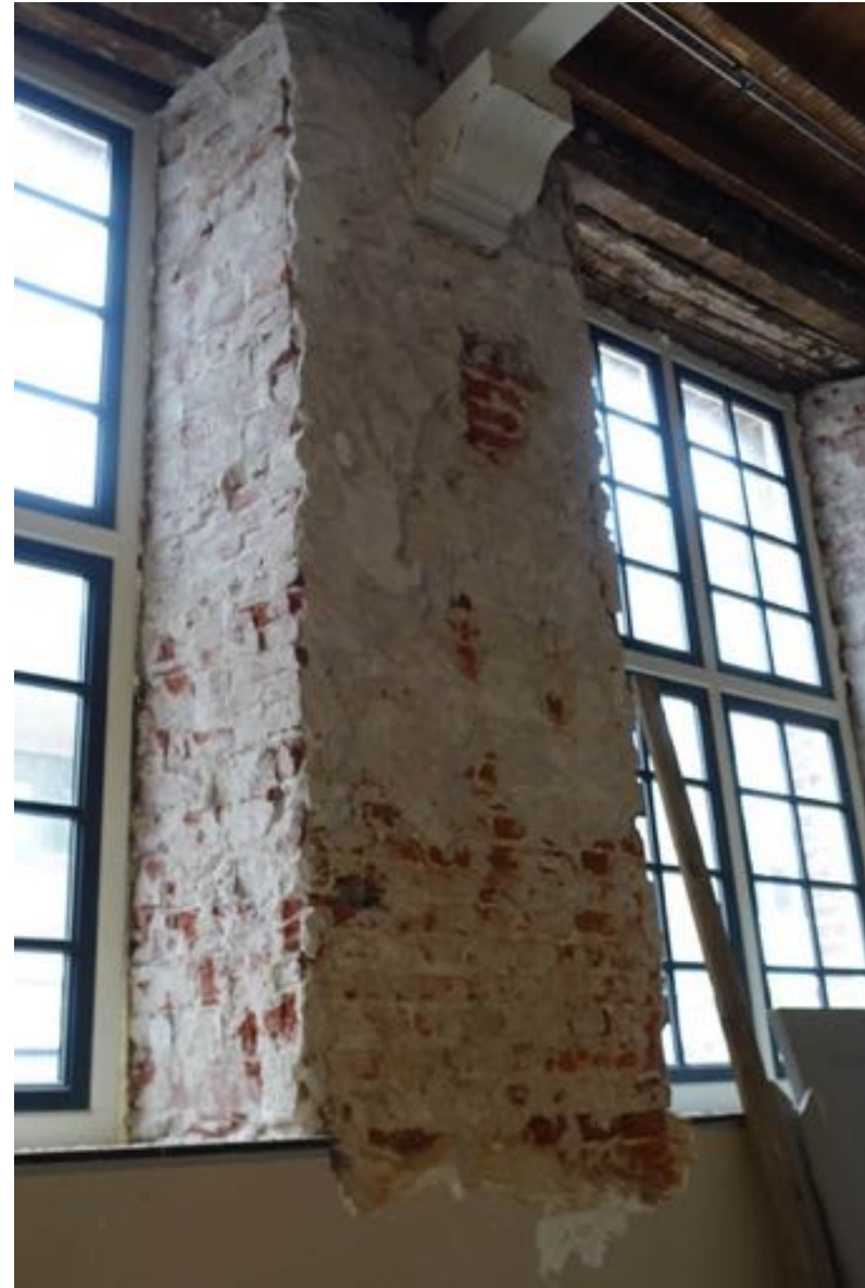
Deze dagkant werd in 1912 bijna volledig beklampt.
