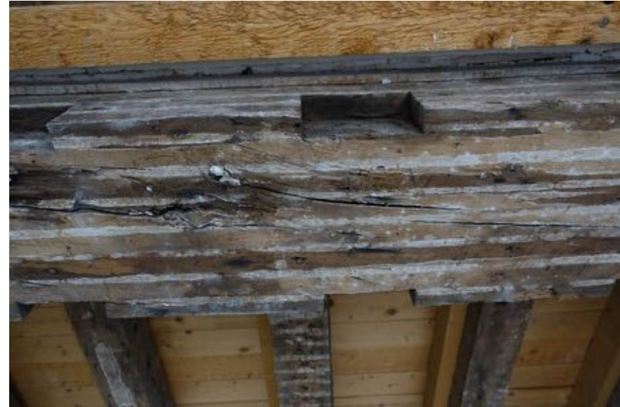
Detail van één van de 'reguliere' oorspronkelijke kepen t.b.v. oplegging van de kinderbinten.
