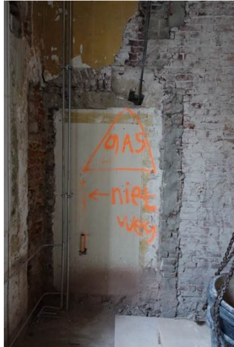
Detail nis, met onder de segmentboog een betonlatei of restant van een vloer.
