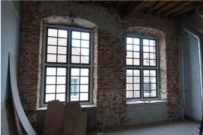
Overzicht vensters ruimte 07 op de verdieping. Onder de vensterbanken waren eerder nissen aanwezig.
