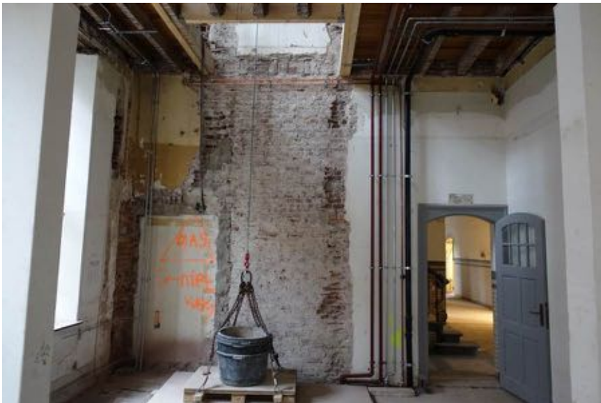
Voorwand van ruimte 02, uitgevoerd in machinale steen, met links een dichtgemetselde nis.
