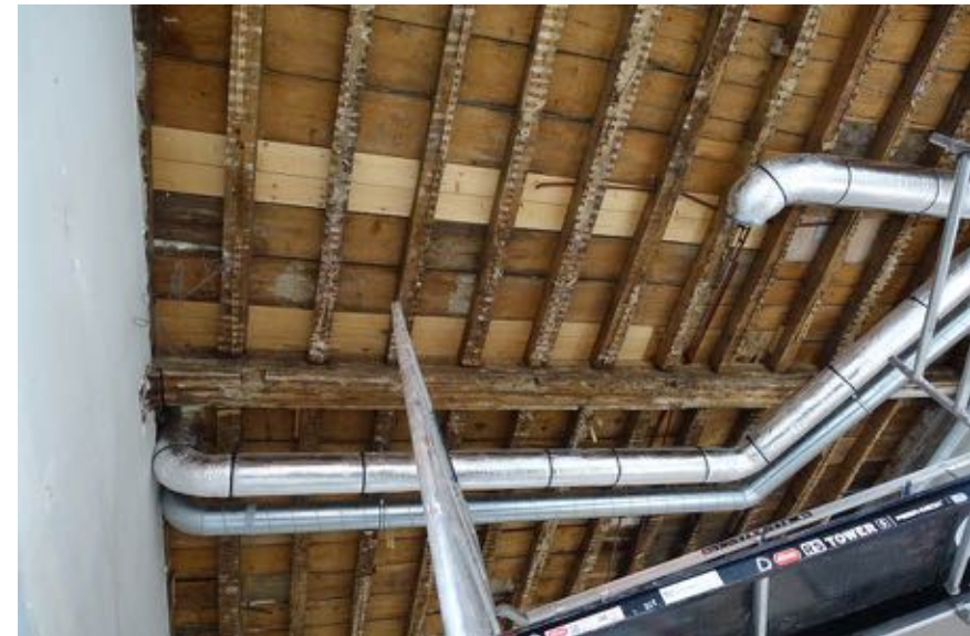
Overzicht samengestelde balklaag boven ruimte 04, richting linker zijgevel.
