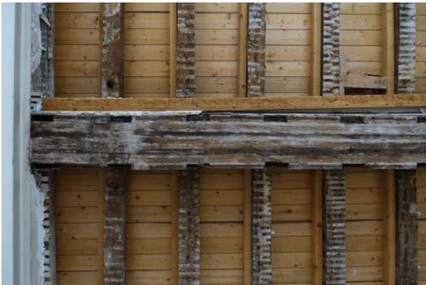
Onderzijde achterste deel van de hergebruikte moerbalk.
