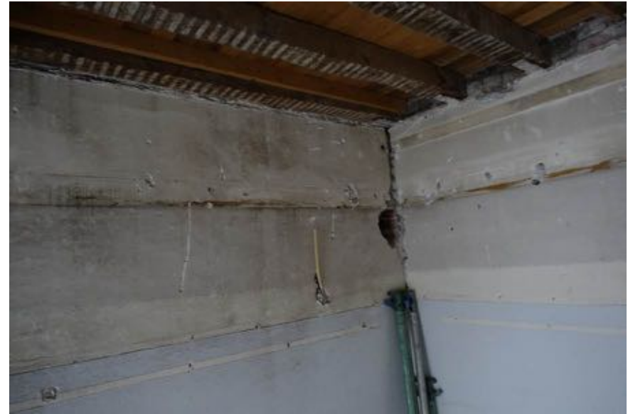
Rechter achterhoek van ruimte 05, waar zichtbaar is dat de gangwand tegen de oudere muur is geplaatst.
