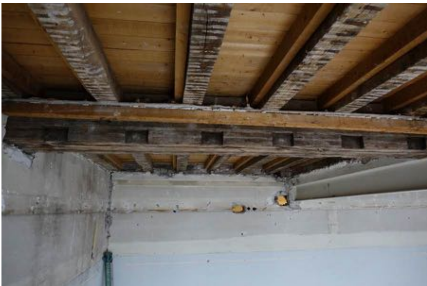
Zicht onder de balklaag richting de rechter zijgevel.
