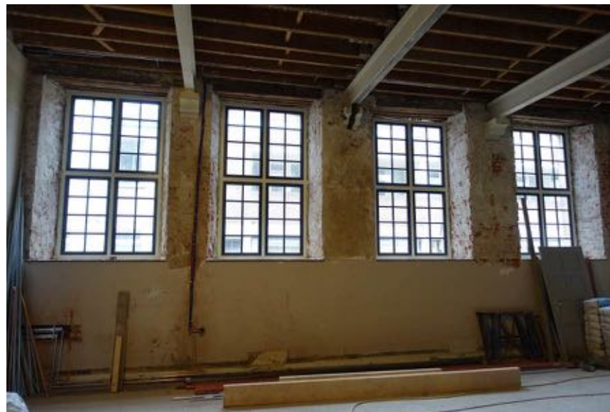
Overzicht vensters linker zijgevel van ruimte BGG 04.
