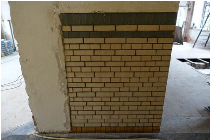
Detail lambrisering van verblendsteen.
