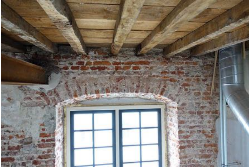
Aansluiting van de kinderbinten op de linker zijgevel.
