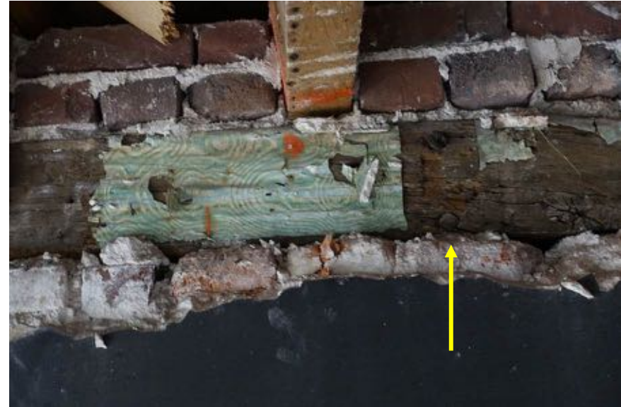
Detail balk met behangfragment en boven de pijl twee toognagels.
