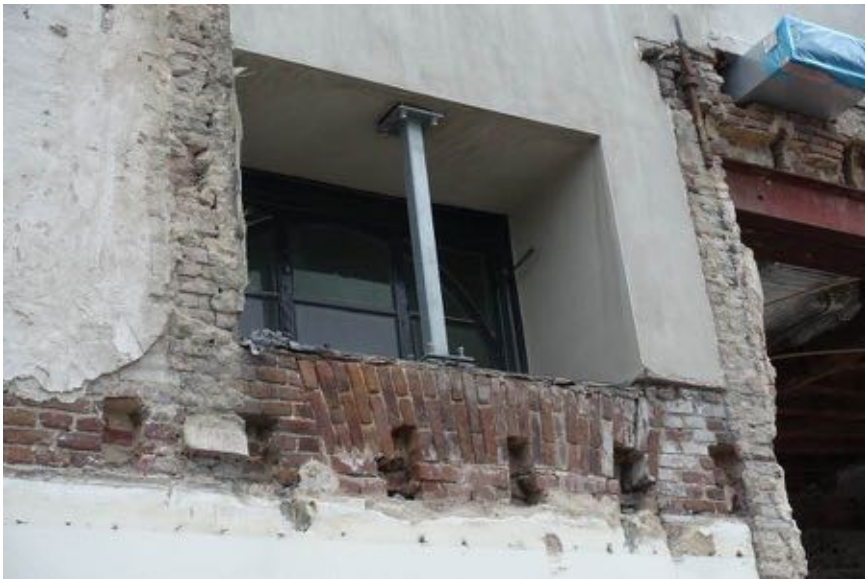
Anderhalfsteens streek van machinale steen uit 1912 onder het bovenlicht in de achtergevel van ruimte 05 op de verdieping.
