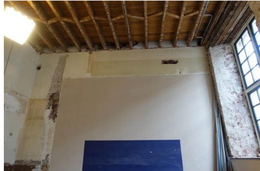
Overzicht voorwand van ruimte 04. Deze muur werd in 1828, deels met hergebruikte baksteen vanaf de fundering opgemetseld.
