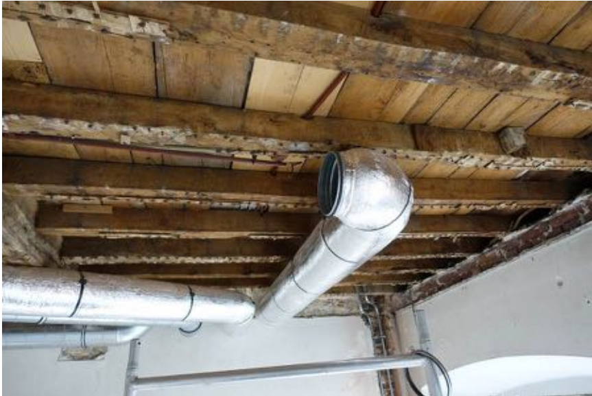
Overzicht samengestelde balklaag boven ruimte 04, richting achtergevel.
