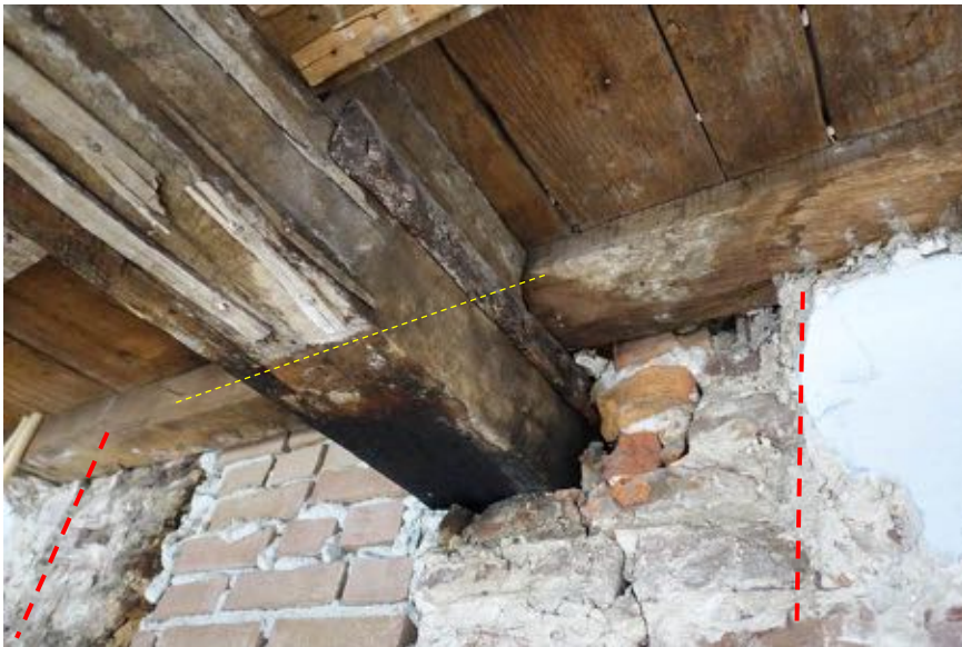
Detail balkoplegging met zijanten van schouw. De stippellijn op de balk markeert de voorzijde van de schouw.
