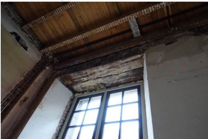
Venster in de rechter zijgevel van ruimte BGG 02.
