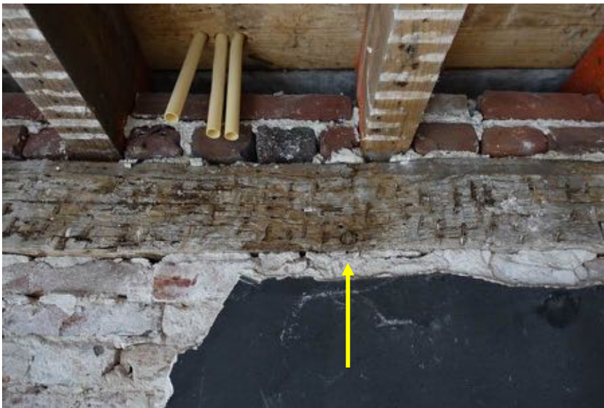
Detail balk met boven de pijl twee toognagels.
