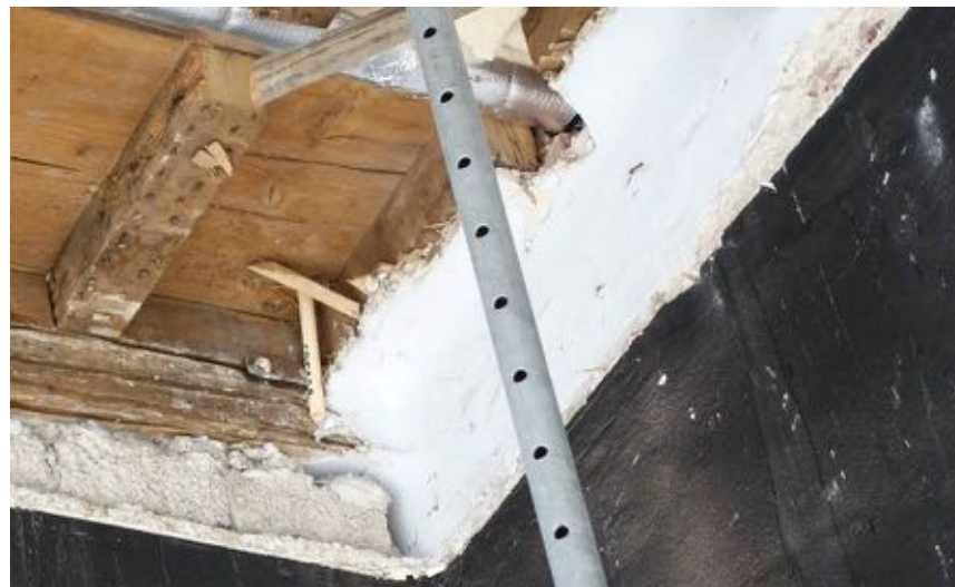
Bij de rechter voorhoek van ruimte 06 werd de wand van drijfsteen (tussen 01 en 06) onder de kooflijst geplaatst.
