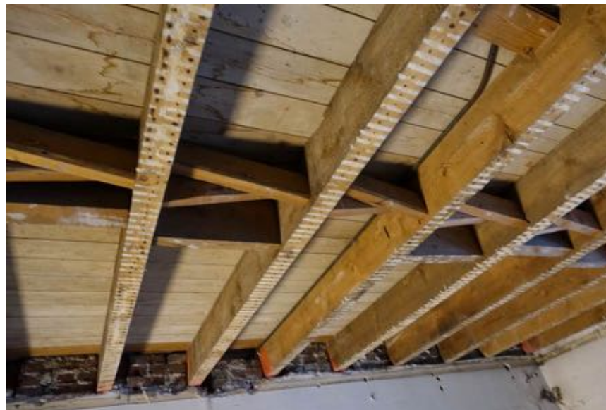
Overzicht enkelvoudige balklaag boven 06, met tussen de balken Andreaskruizen en latere blokken om het wisselen tegen te gaan.
