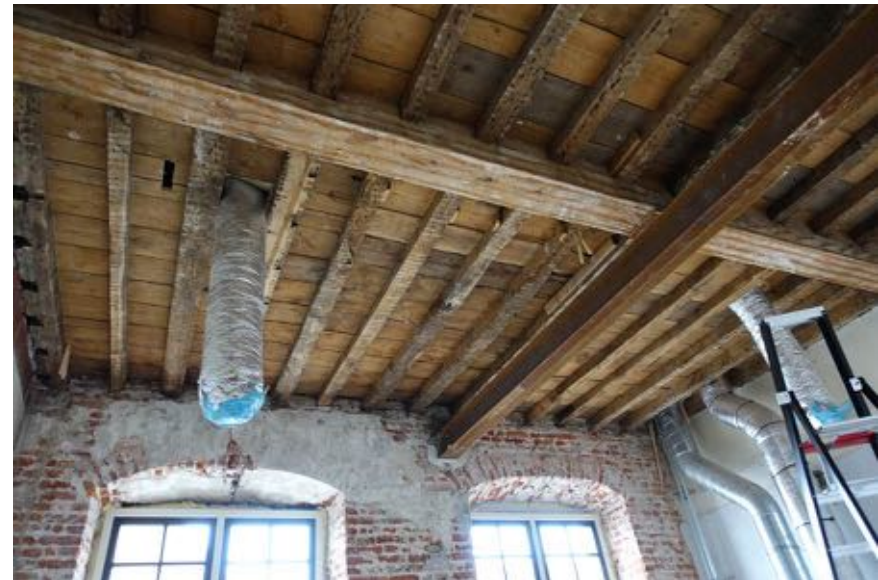
Overzicht balklaag boven ruimte 07.
