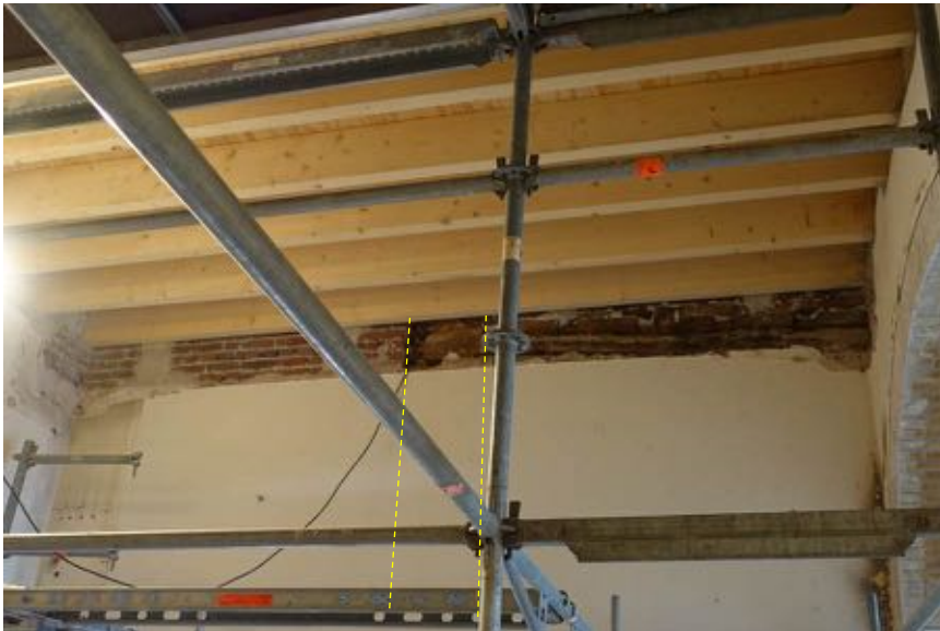
Bovenzijde van de linkerwand van de overloop (01). Op de moerbalk tekent zich de ter plaatse van het trappenhuis gesloopte dwarsmuur nog af.
