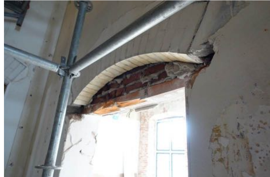
Doorgang linkerwand met aan de achterzijde een recente klamp boven een staltonlatei.
