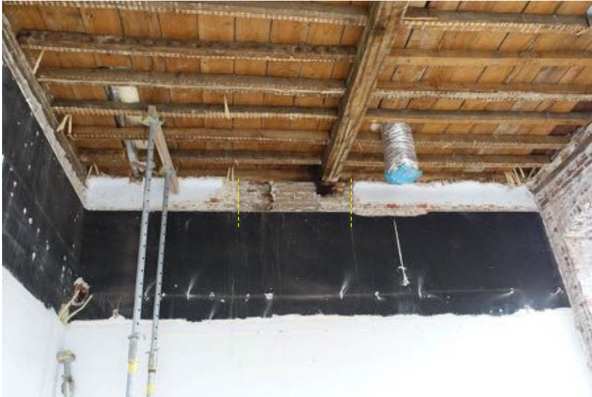
Voorwand van ruimte 06, met rond de balkkop de aftekening van een schouw.
