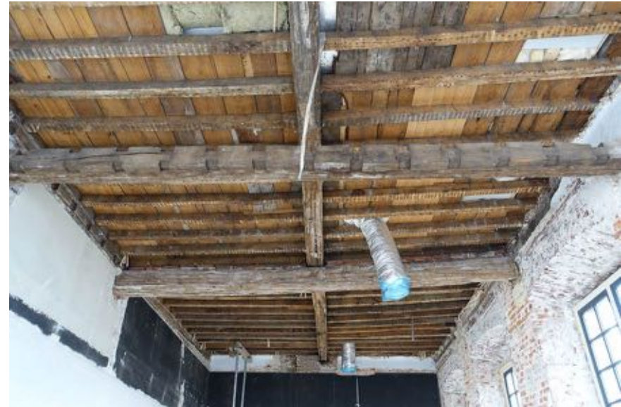
Overzicht balklaag boven ruimte 06, richting de voorgevel.
