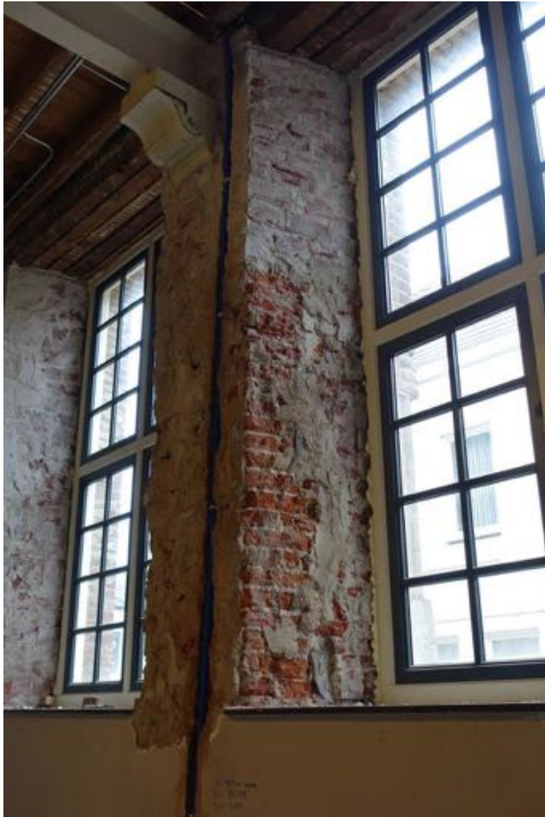
Detail van de behakte en deels beklampte dagkant.
