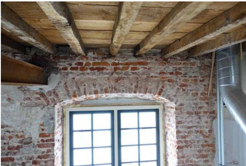
Detail oorspronkelijke ontlastingsboog boven het rechter venster van ruimte 07.
