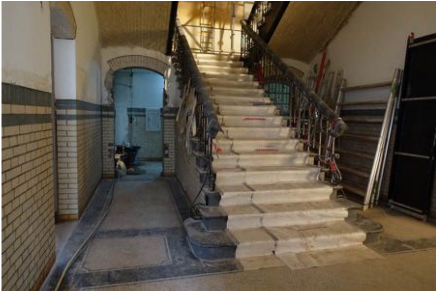
Overzicht trappenhuis (03) met al grotendeels gereinigde lambriseringen van verblendsteen uit 1912.
