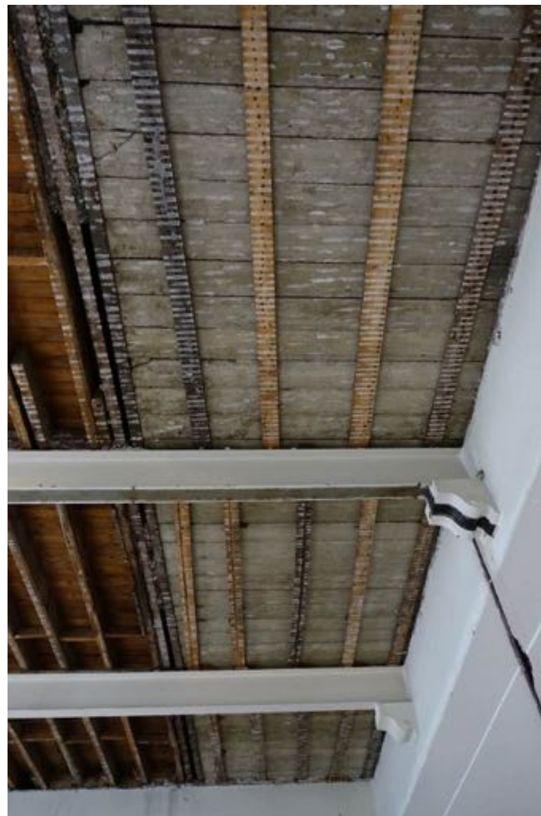
Zicht op de in 1912 aangelegde vloer van Siegwartbalken boven ruimte 04.
