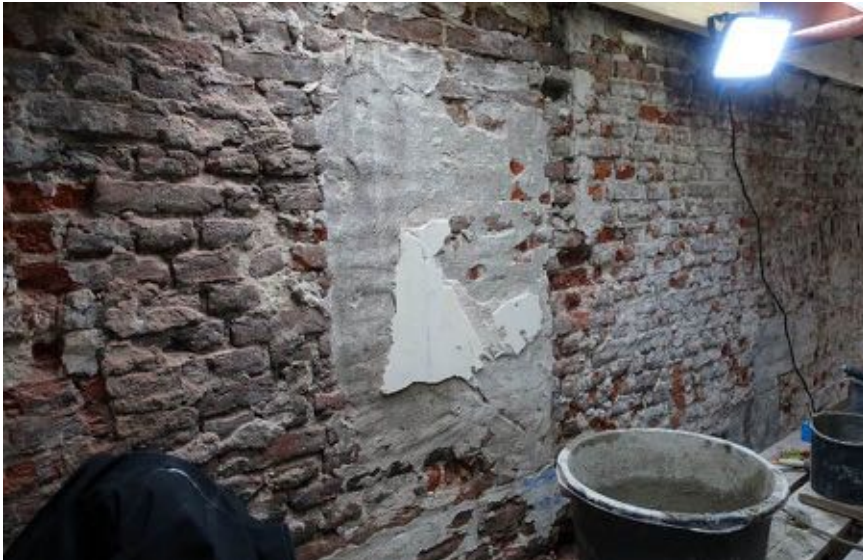
Vermoedelijk in 1828 dichtgemetselde rechthoekige opening in het midden van de begane grond van de achtergevel.
