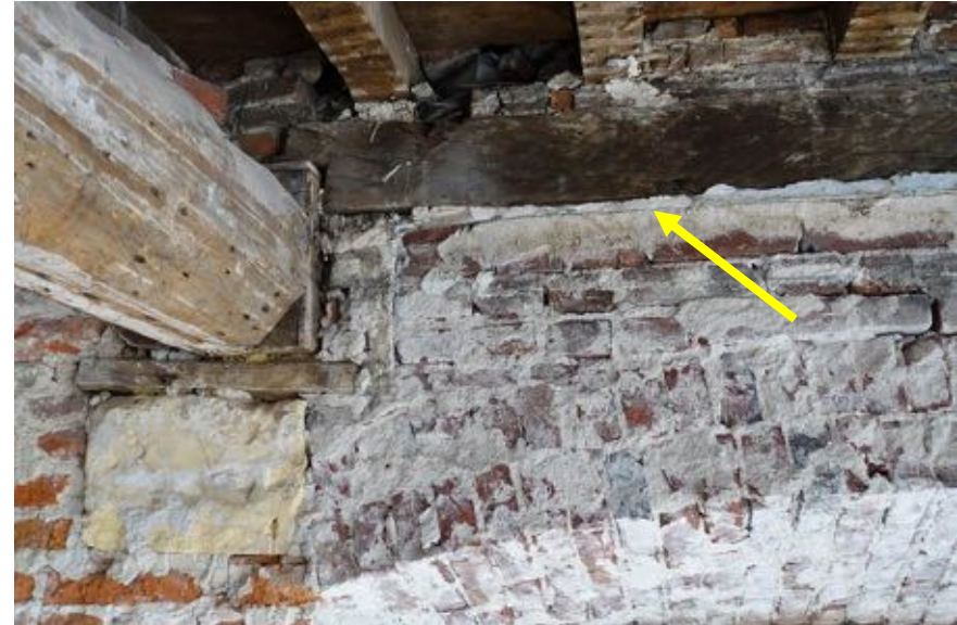
Detail van de oplegging van de grenen onderslagbalk en rechts de boog en vulling uit 1912. Bij de pijl is de gepleisterde dagkant van het venster uit 1828 herkenbaar.
