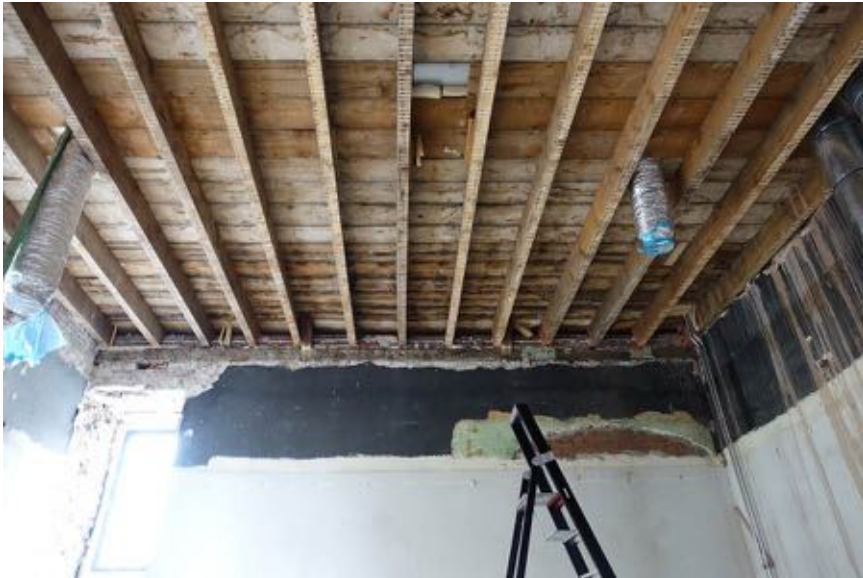
Overzicht linker gevel van ruimte 08 op de verdieping. Rechts is een dichtgemetselde opening of nis zichtbaar.
