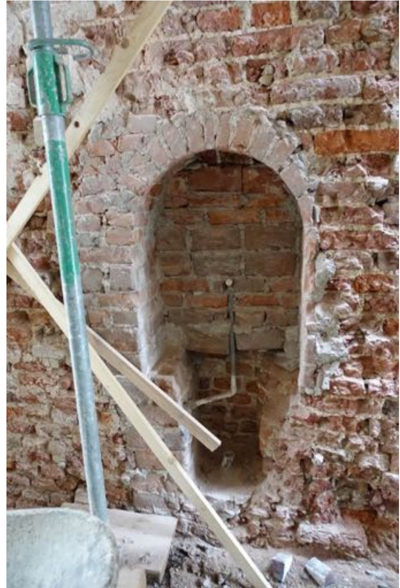
In 1912 in het midden van de achtergevel ingevoegd nisje t.b.v. een fonteintje.
