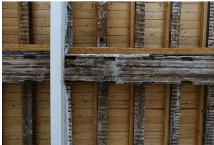
Onderzijde hergebruikte moerbalk, gedeelte direct vóór ijzeren onderslag.
