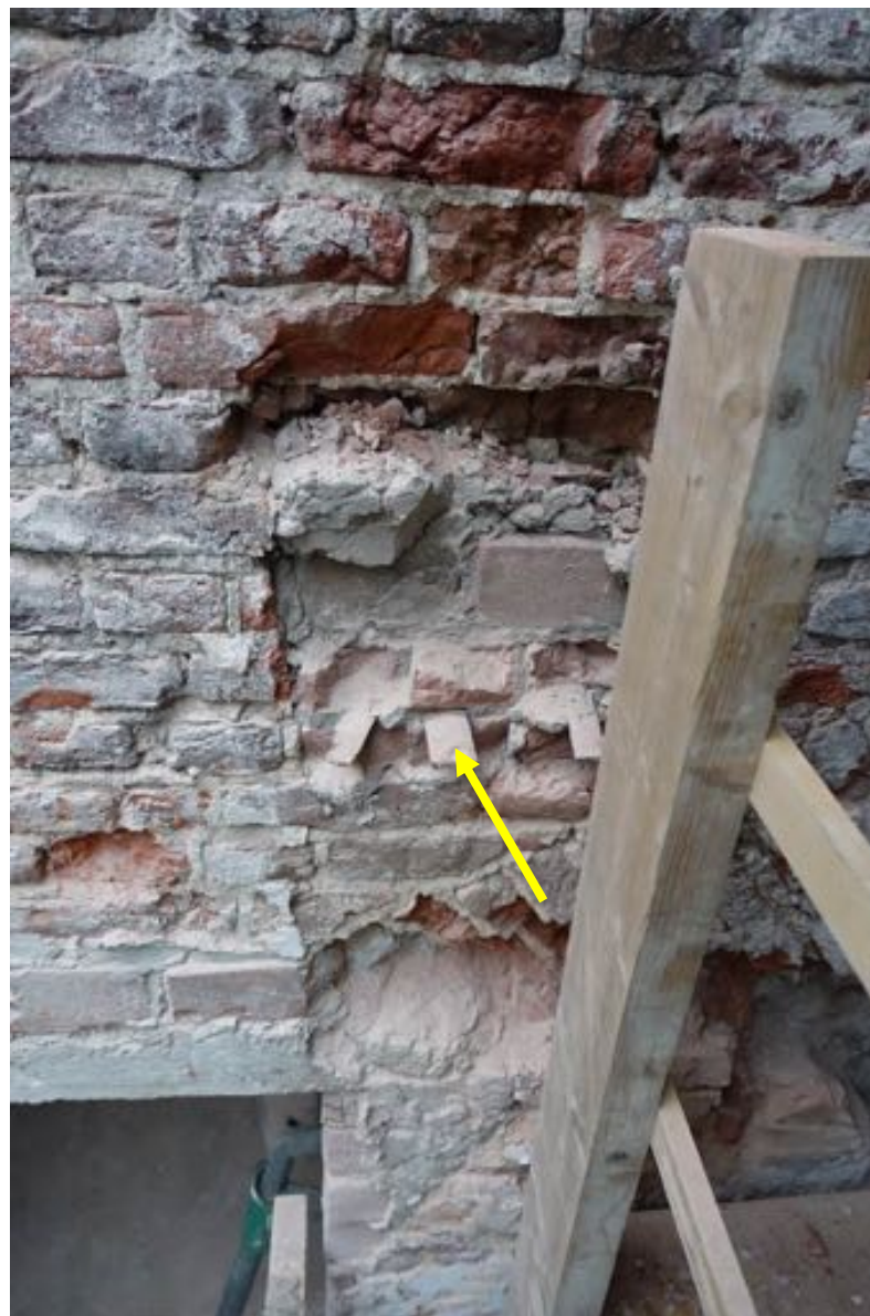
Inkassing van de recent gesloopte muur uit 1912, met bij de pijl drie ankerstrips.
