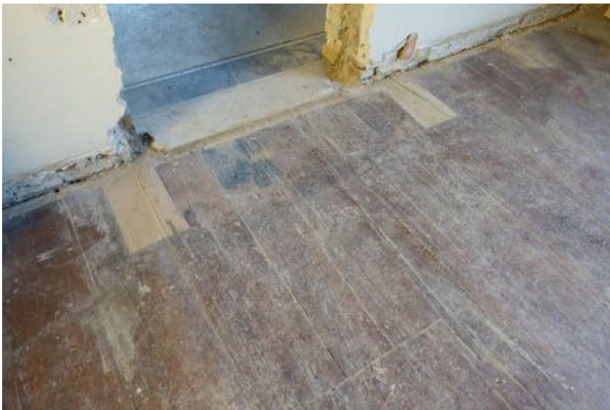
Aftekening van 'penanten' naast de toegang vanuit de middengang.
