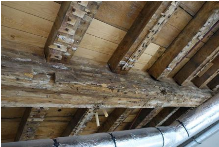
Detail hergebruikte moerbalk met in de onderrand kepen van wandstijlen.
