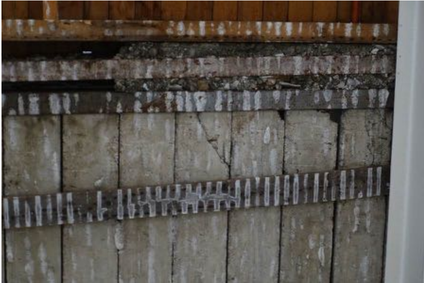
Detail onderzijde vloer van Siegartbalken.
