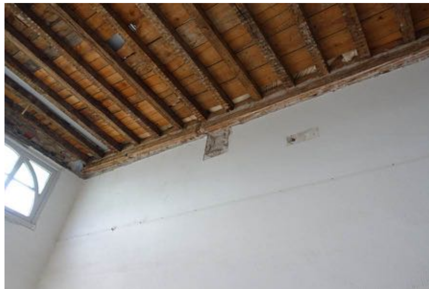
Boven de rechter gangmuur herkenbare moerbalk.
