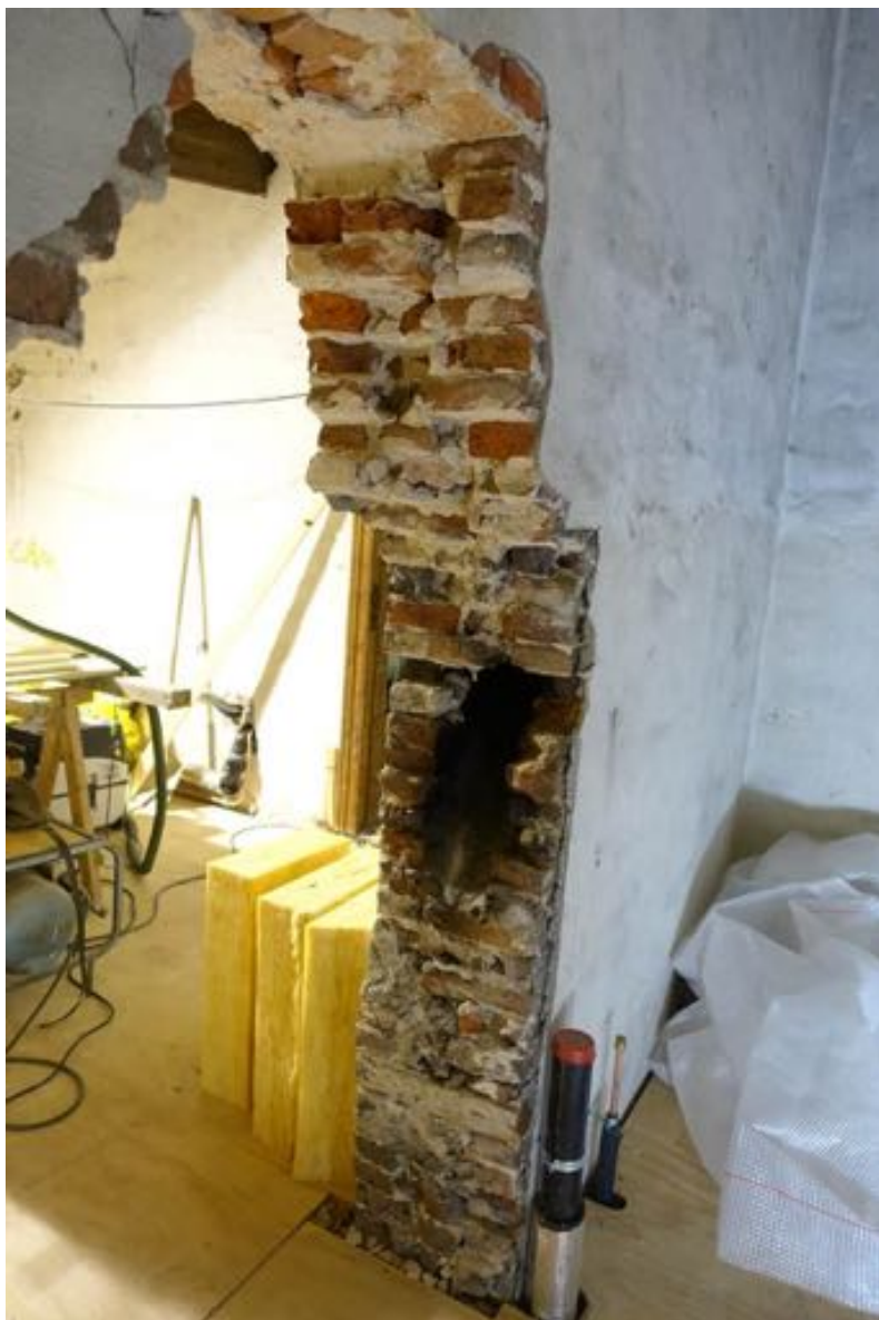
Zicht in de doorbraak door de voorste brandmuur op de zolder.
