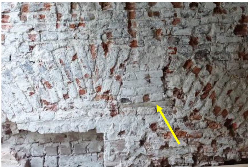
Detail van het middendeel van de boog, met boven een grenen plankje (pijl) een inboeting.
