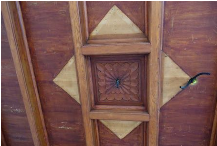
Detail van het middenrozet. De lichte vlakken geven de oorspronkelijke omvang van het rozet weer.
