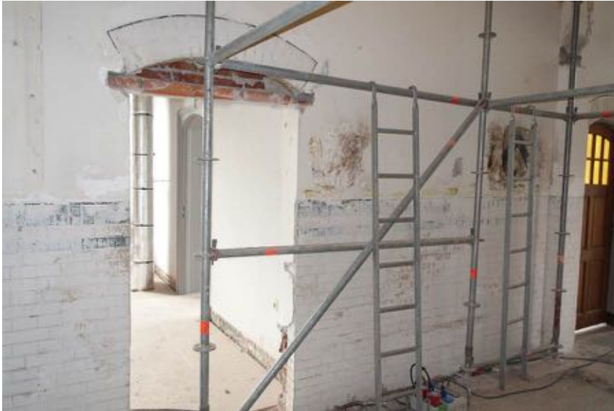
Linkerwand van de overloop (01) met deels gereinigde lambrisering van verblendsteen.
