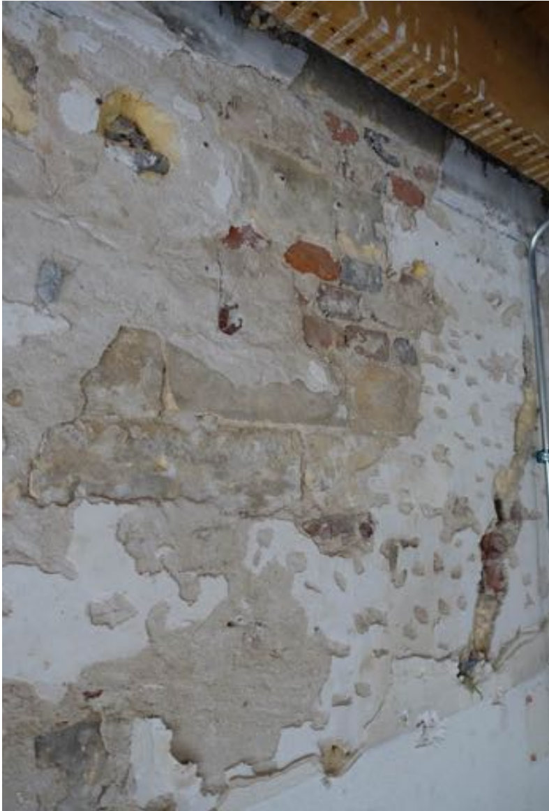
Detail van de in 1828 hergebruikte mergelblokken van ca. 10 x 30/35 cm, afgewisseld met lagen baksteen.
