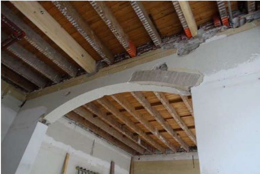
Brede steens segmentboog van verblendsteen tussen de ruimtes 01 en 02.
