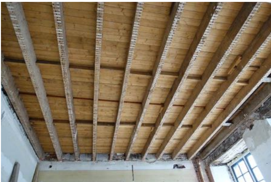
Overzicht enkelvoudige balklaag boven ruimte 01, richting de achtergevel.
