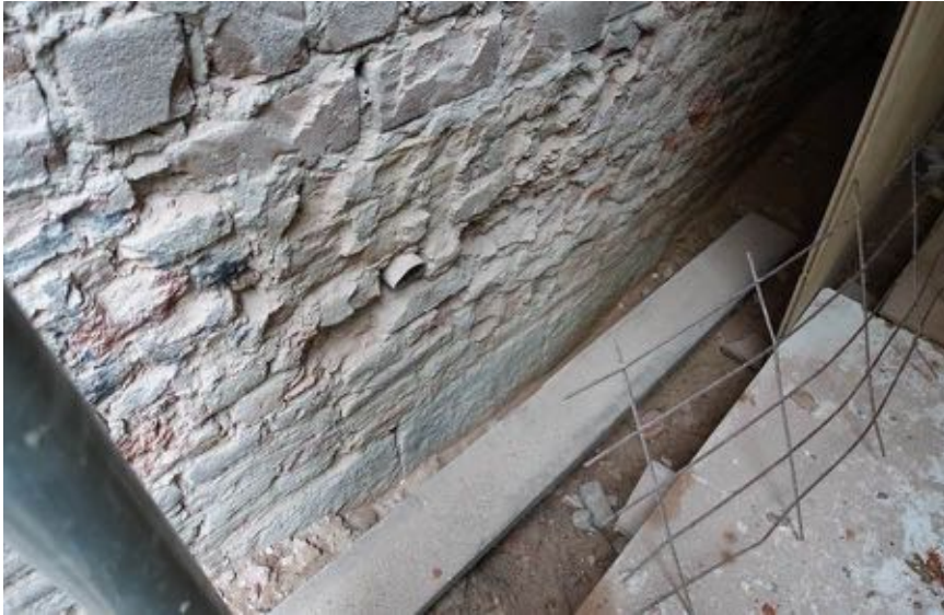
Een plint van hardstenen blokken bij de achtergevel. De bovenzijde ligt globaal ter hoogte van het huidige straatniveau ter hoogte van de achtergevel.
