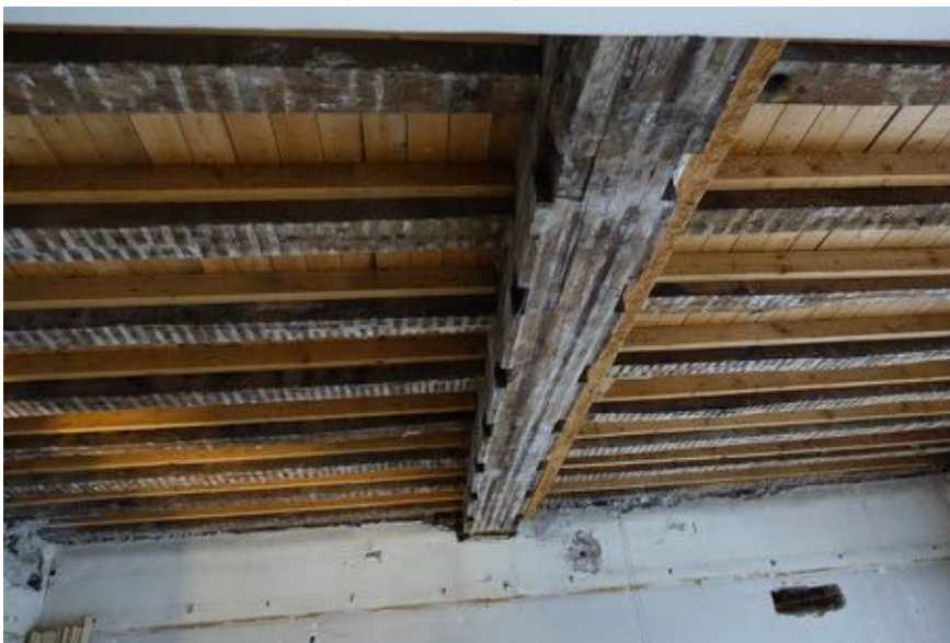
Overzicht van de op zijn kop hergebruikte eiken moerbalk, richting voorgevel.
