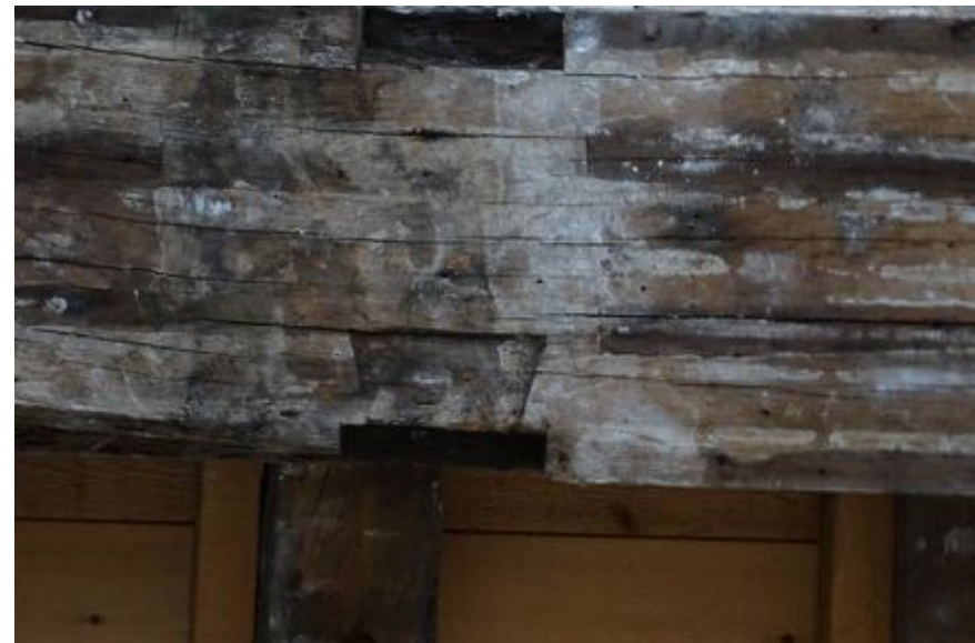
Detail zwaluwstaartvormige keep voor oplegging kinderbint.
