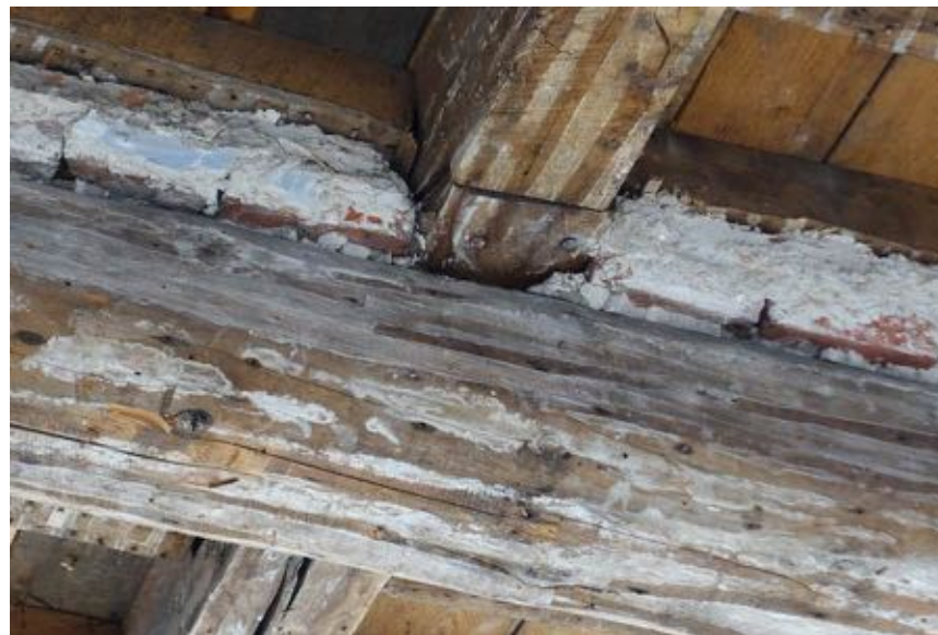
Baksteenvulling boven de grenen onderslag, met aan de voorzijde een gepleisterde afwerking.
