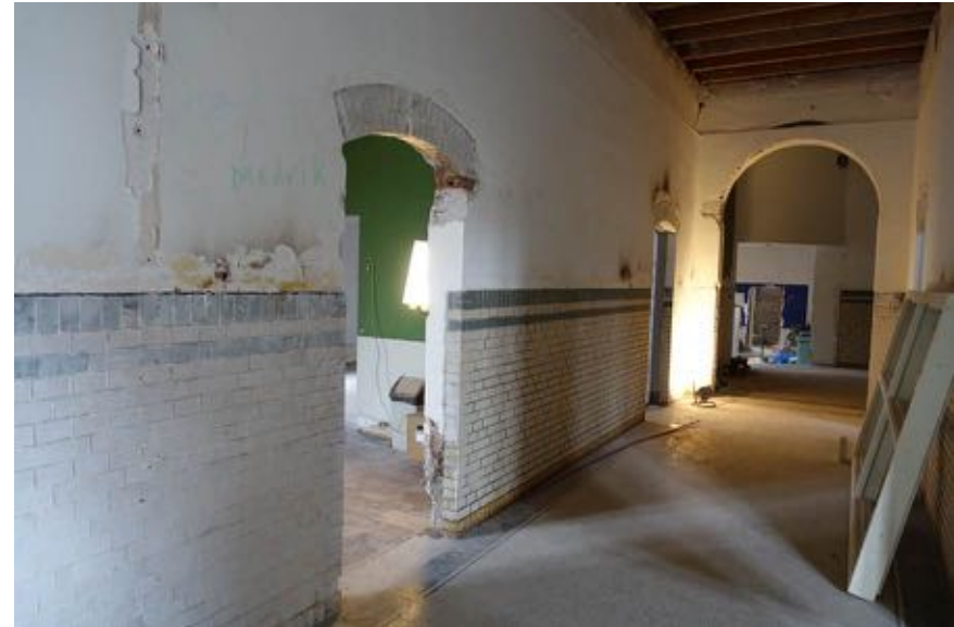
Overzicht linker wand van de middengang (07) met deels gereinigde lambrisering.
