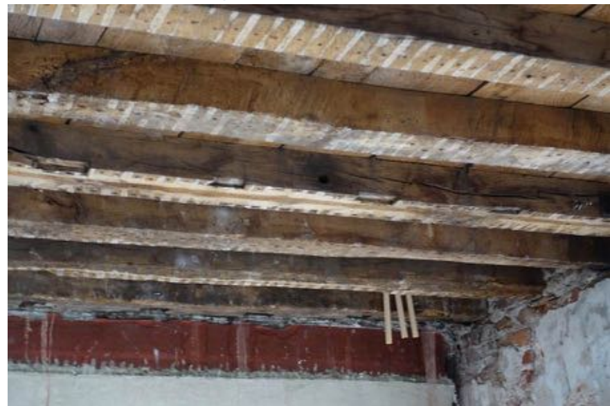
Detail kinderbinten met sporen van hergebruik.
