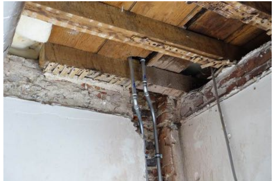
Detail van de rechter achterhoek van ruimte 04, met rechts de beklamping (1912) van de rechter zijgevel welke tegen de onderzijde van het stucplafond uit 1828 aansluit.
