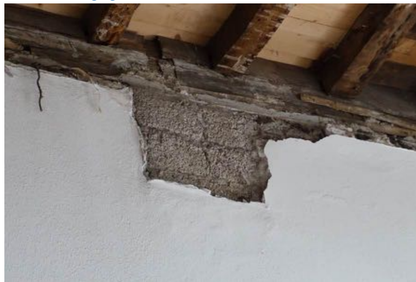
Bij de moerbalk boven de linker gangmuur zijn tussen de balk en de muur van drijfsteen uit 1912 resten van het stucplafond uit 1828 behouden gebleven.
