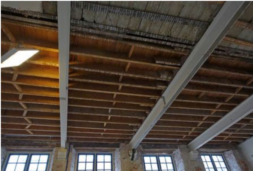
Overzicht enkelvoudige balklaag met ijzeren onderslagen boven 04.
