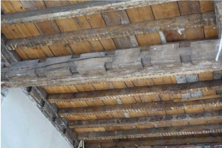
Detail van de op enige afstand onder de balklaag aanwezige hergebruikte moerbalk.
