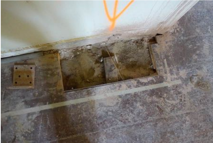
Bij deze sparing naast de achterwand van ruimte 06 zijn de in het zand gelegde ribben zichtbaar.
