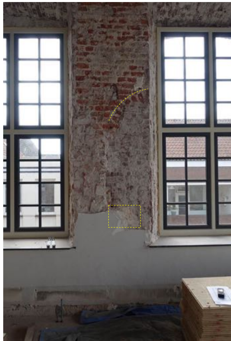
In de muurdam tussen de twee middelste vensters is een deel van een halfsteens boogje zichtbaar. Ook is een mergelblok aanwezig. Hierboven bevond zich waarschijnlijk tot 1912 de grenen onderslag van een extra balklaag.
