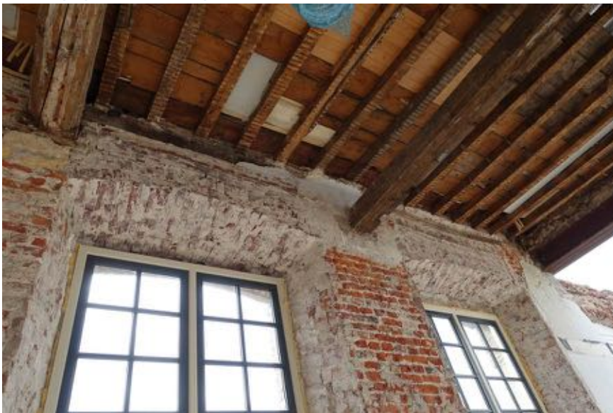
Detail bovenzijde rechter twee vensters.
