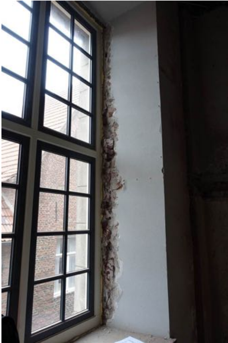
Dagkant van een venster in de rechter zijgevel van ruimte 04. Ouder muurwerk gaat hier achter de beklamping uit 1912 schuil.
