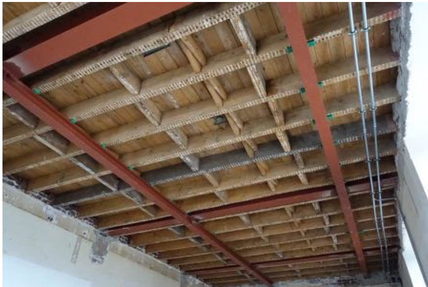
De recent versterkte enkelvoudige balklaag boven ruimte 08.
