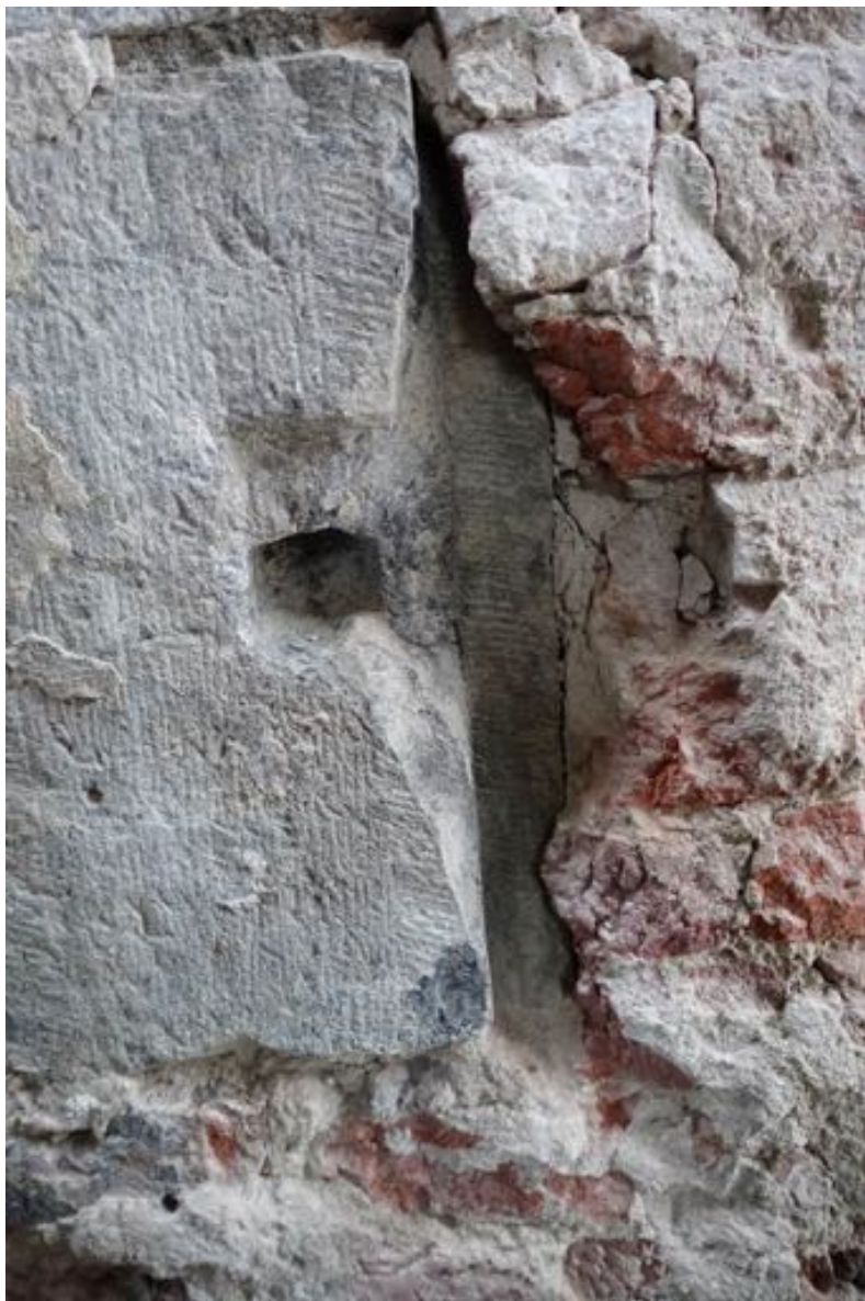
Bij het onderste deel van de opening is een luikspinning van ca. 35 x 40 mm aanwezig. Het gat hoort bij een luikduim.
