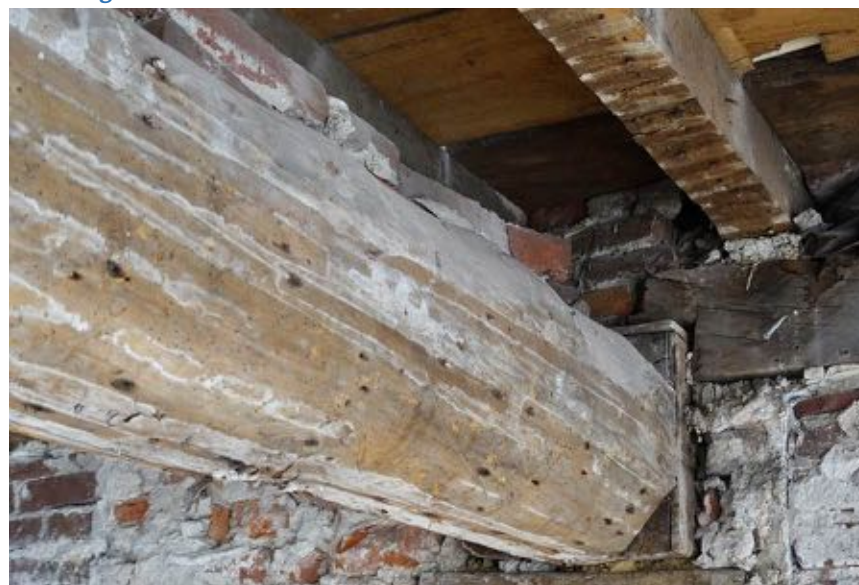
Aan de achterzijde ligt de vulling terug en betreft het vuilwerk.
