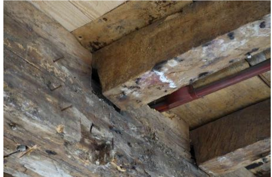
Hoewel de kinderbinten in de oude kepen werden gelegd is de passing soms erg slordig. De kinderbinten hebben hier een zogenaamd 'hakje' bij de oplegging.
