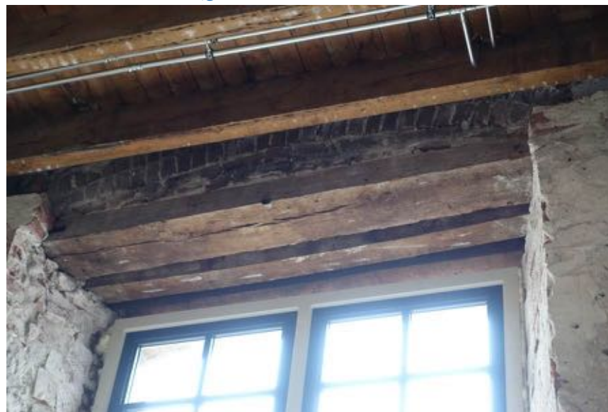
Detail (hergebruikte) eiken lateien en boog van machinale steen boven venster van ruimte BGG 04.
