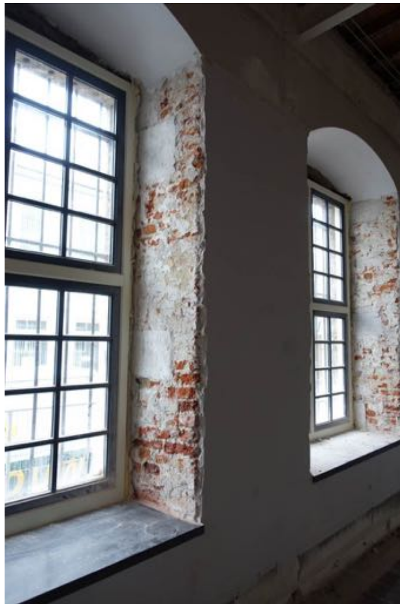
Oorspronkelijke dagkanten, met hier zichtbare hardstenen blokken bij de vensters van ruimte 05 op de begane grond.
