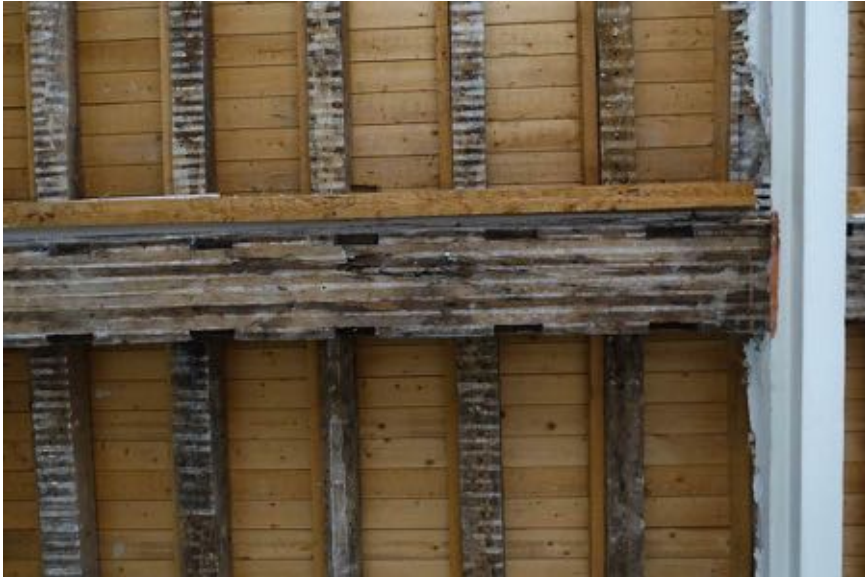
Onderzijde hergebruikte moerbalk, gedeelte direct achter de ijzeren onderslag.
