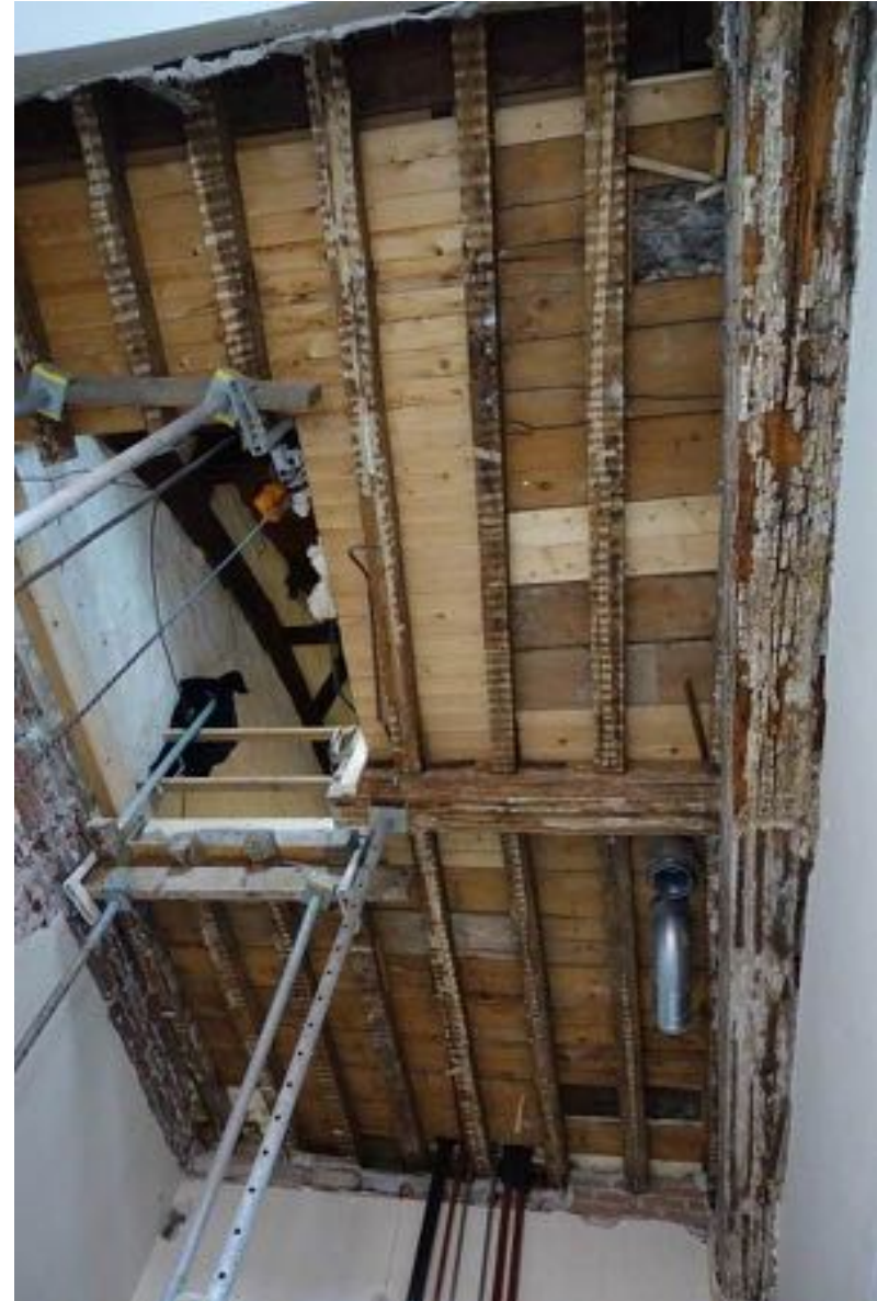
Overzicht balklaag boven ruimte 04, richting de linker zijgevel.
