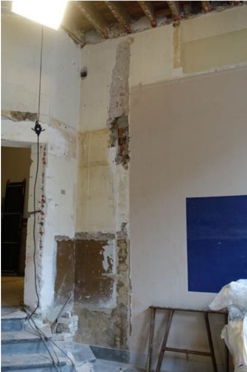
Linker voorhoek van ruimte 04, waar delen in machinale baksteen en poriso voortkomen uit de in 1981 gerealiseerde balieruimte.
