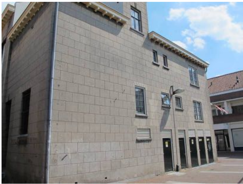
Overzicht van de achtergevel van de achterbouw
