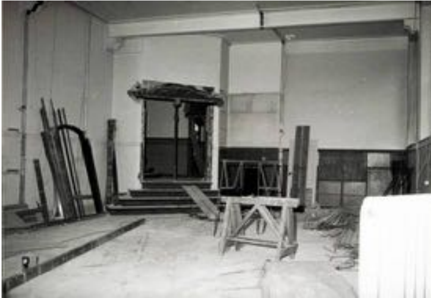
Zicht richting de voorwand van de linker achterzaal, met links nog de diagonale trap vanaf het trappenhuis. Bron: Collectie Gemeente Weert
