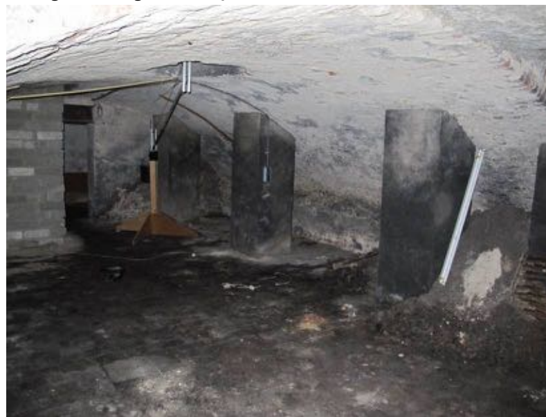
Kolommen uit 1912 in achterste rechter kelderruimte
