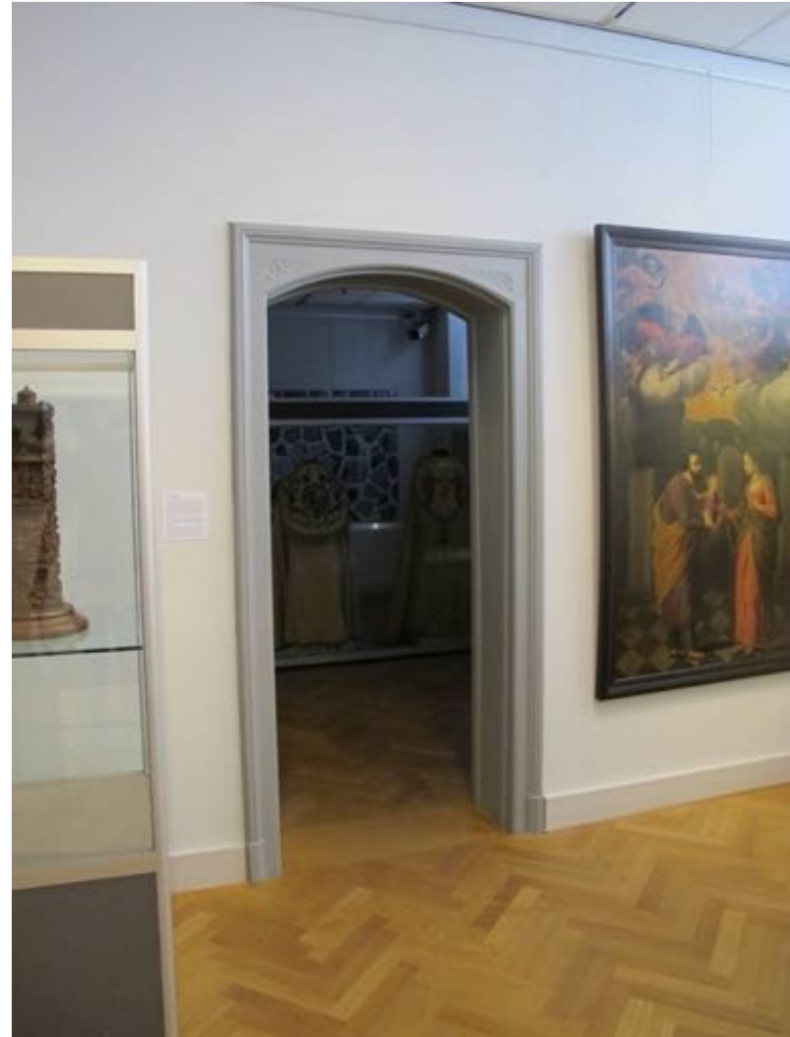
Eén van de oude deurkozijnen met omlijstingen. Bij de burgemeesterskamer waren de deuren dubbel uitgevoerd.
