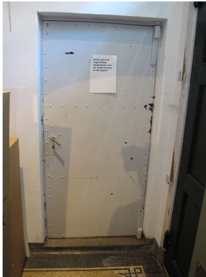
Stalen deur als toegang tot de over drie bouwlagen doorlopende kluisruimte (0.18)
