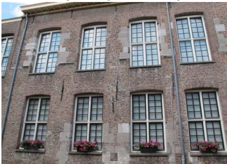
De vensters in de linker vier traveeën met nog restanten van de oorspronkelijke dagkanten met natuursteenblokken.
