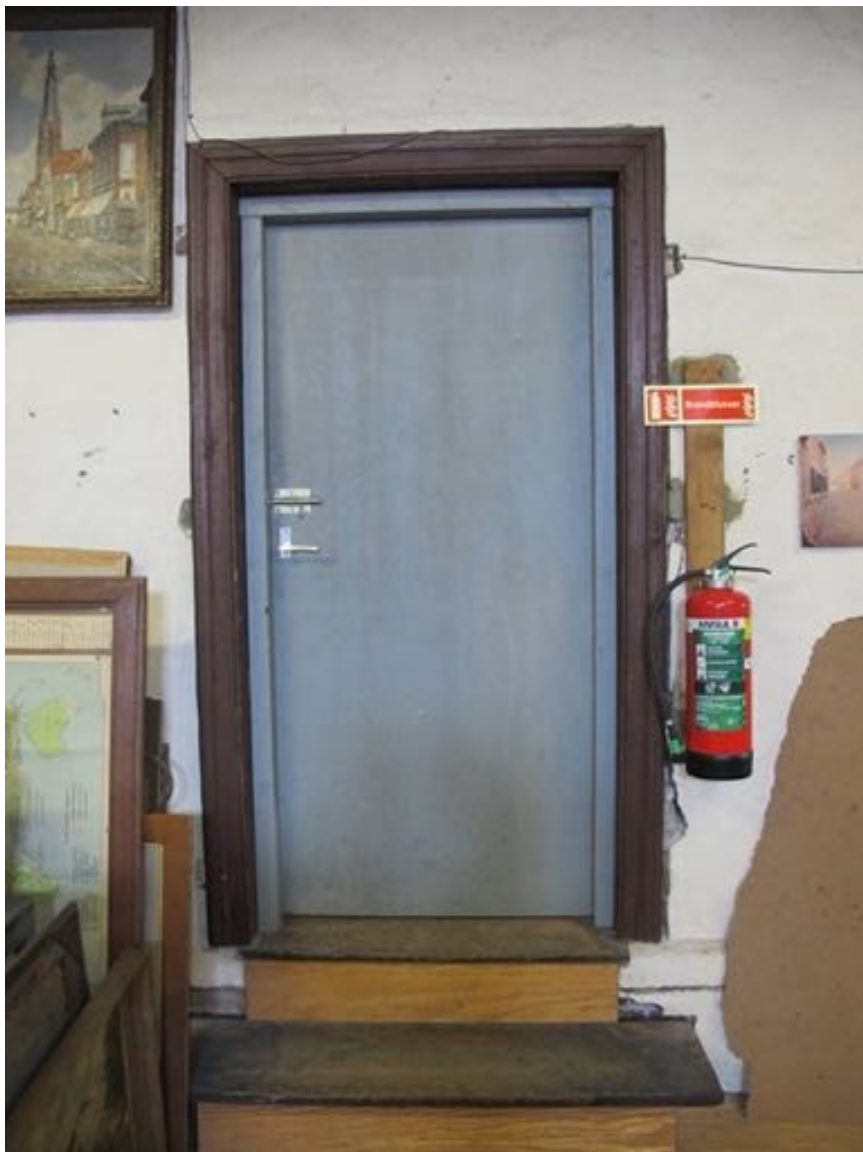
Binnen het oudere kozijn tussen 2.02 en 2.03 is een nieuw kozijn met vlakke deur ingevoegd
