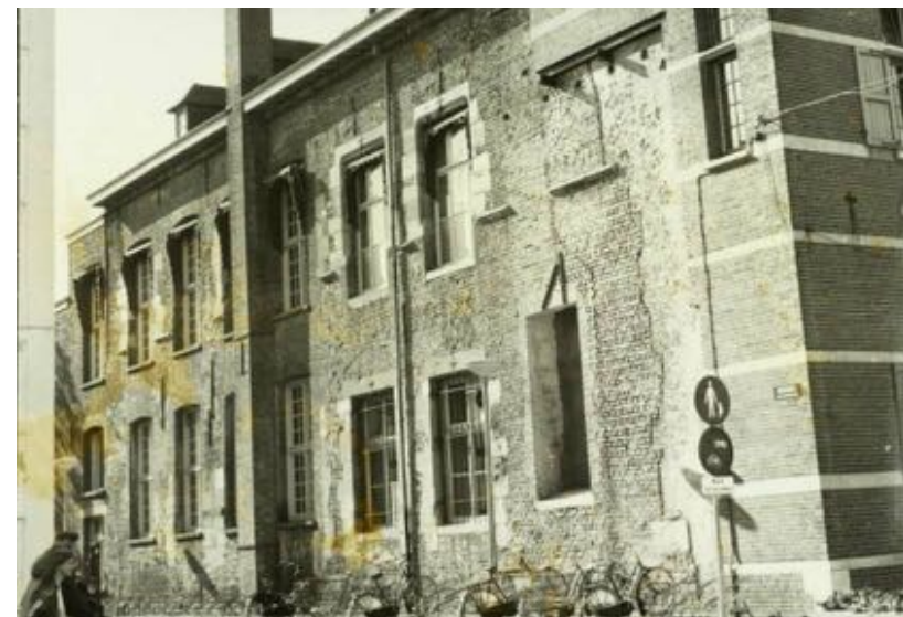
De linker zijgevel na de sloop van het buurpand in 1968. Bron: Collectie Gemeente Weert
