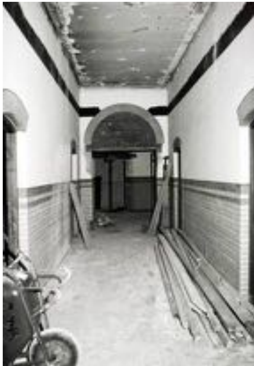
De gang op de begane grond richting het trappenhuis. Bron: Collectie Gemeente Weert
