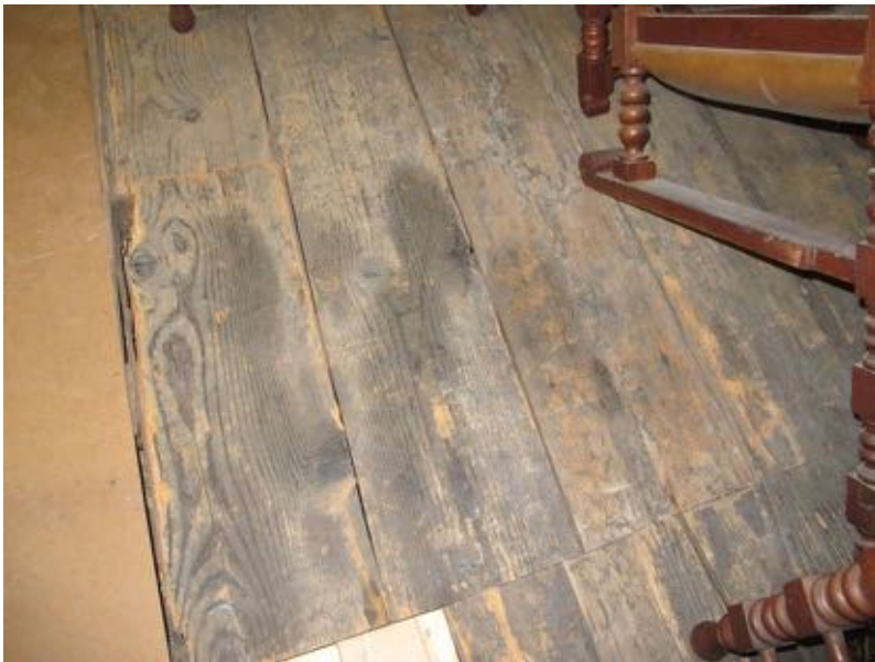
Deels over de zolderbalklaag aanwezige oudere vloerdelen (1828)
