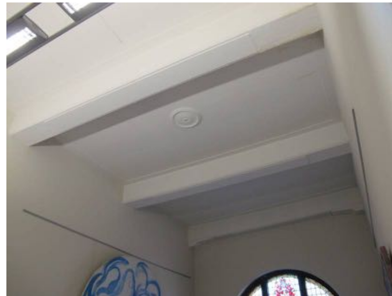
De 'balken' boven het trappenhuis blijken lege koven van stucwerk
