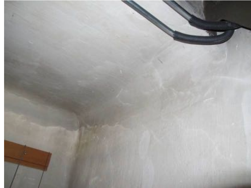
Vlak gepleisterd plafond met afgeronde hoeken in kluis
