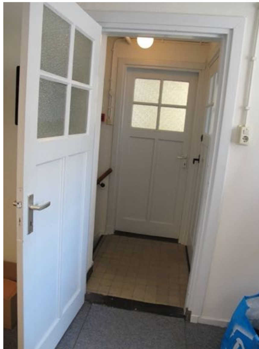
Zicht op de tussen de beide kamers gelegen overloop (T.01)
