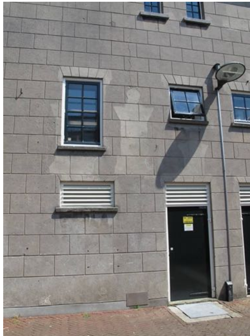
Detail middendeel gevel, waar de oudere (1912) gevelindeling zich aftekent in de lichtere vlakken van het pleisterwerk.
