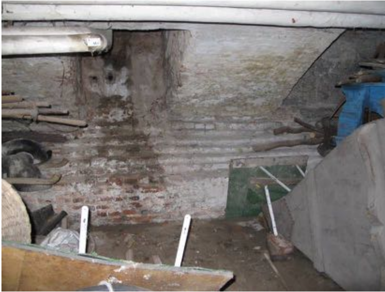
Linker zijgevel in achterste kelderruimte met een uitgemetselde onderbouw
