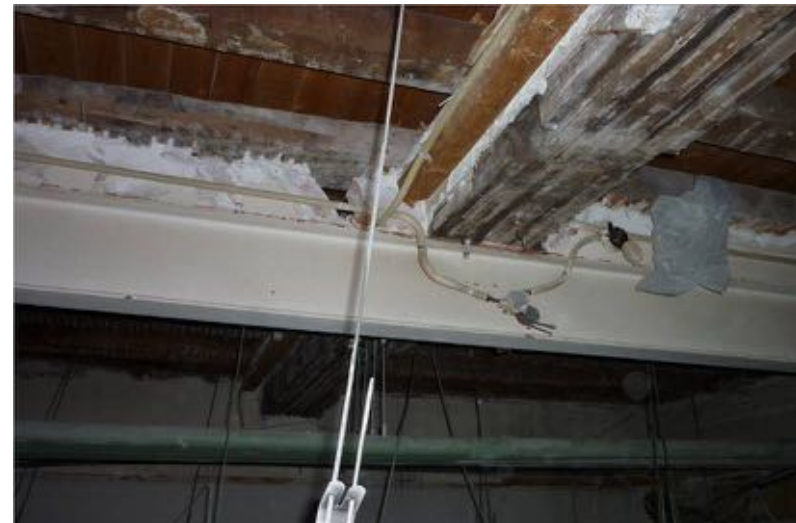
Stalen onderslag en hergebruikte moerbalk boven ruimte 1.03. Bron: Collectie gemeente Weert
