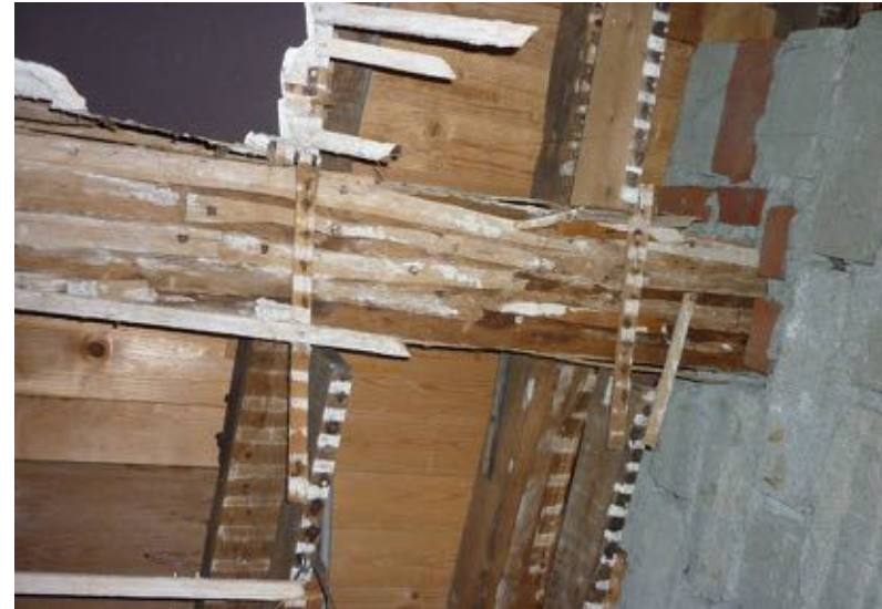
Detail van de in de wand van de liftschacht (rechts) opgenomen hergebruikte balk boven ruimte 1.07
