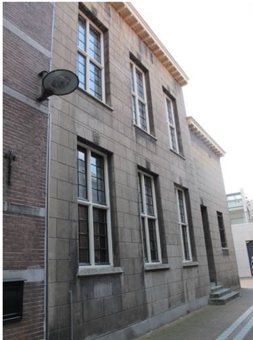
Overzicht van het gepleisterde rechter deel van de gevel
