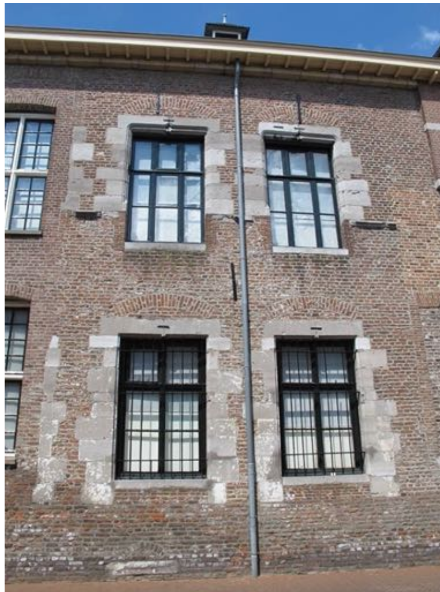
De rechter twee venterassen hebben nog grotendeels de zestiende-eeuwse opzet, al is de hoogte van vensters wel aangepast.
