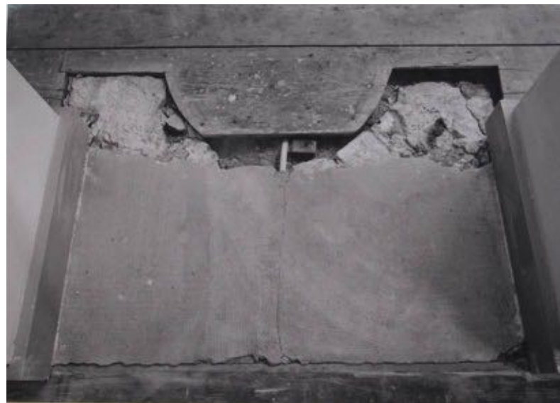
Detail aftekening schouw in doorgang tussen 0.02 en 0.05, gezien richting 0.02. Bron: Collectie Gemeente Weert.
