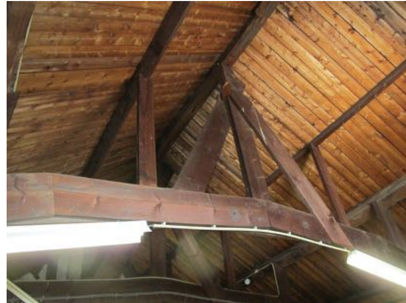
Detail middendeel spanten, met aanpassingen t.b.v. de steilere dakhelling
