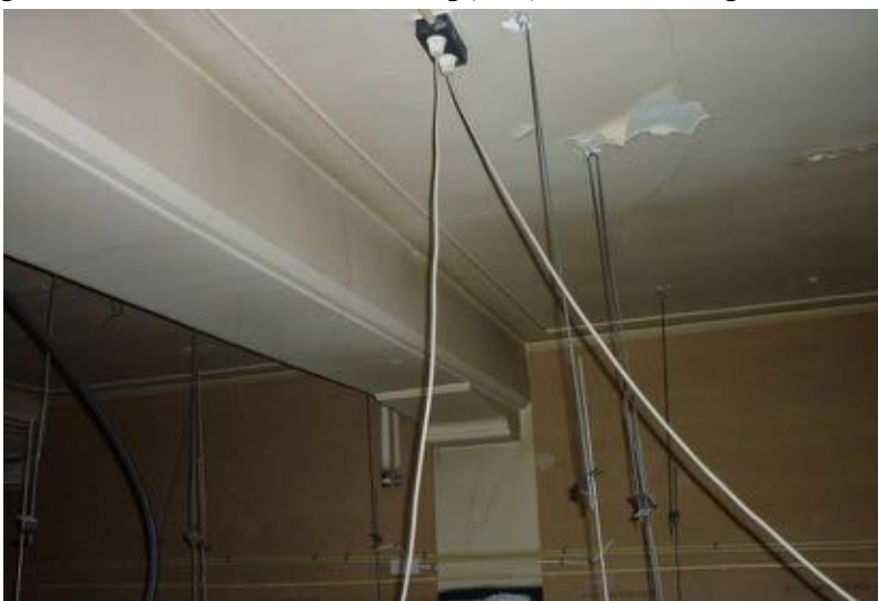
Omstucte stalen balk boven ruimte 1.05. Bron: Collectie gemeente Weert
