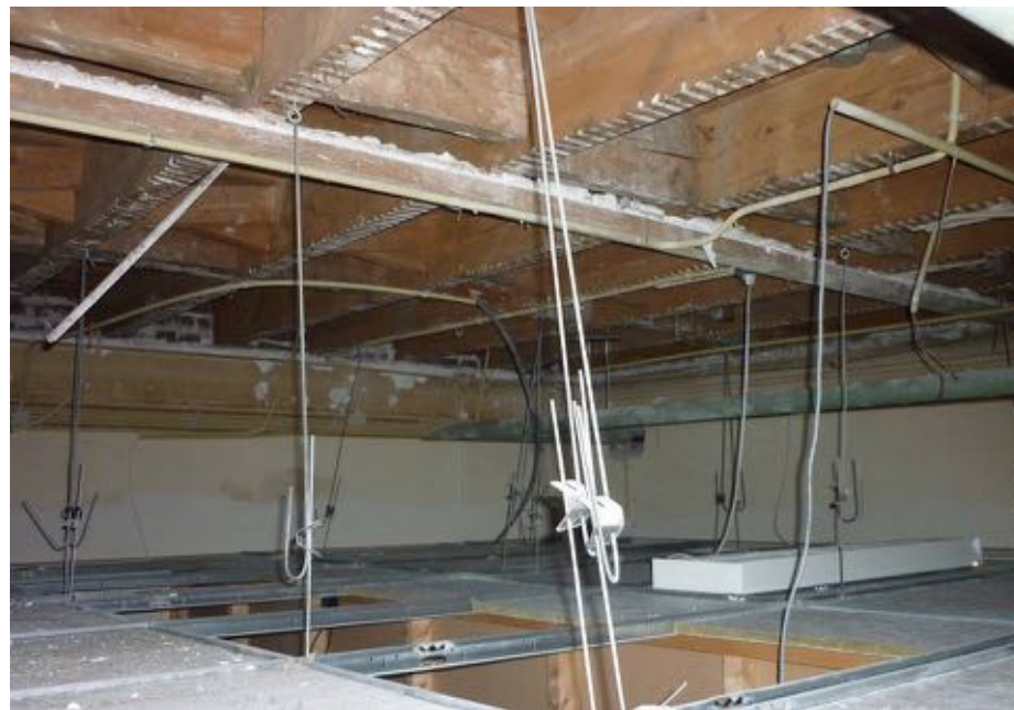
Enkelvoudige balklaag boven ruimte 0.02. Bron: Collectie gemeente Weert
