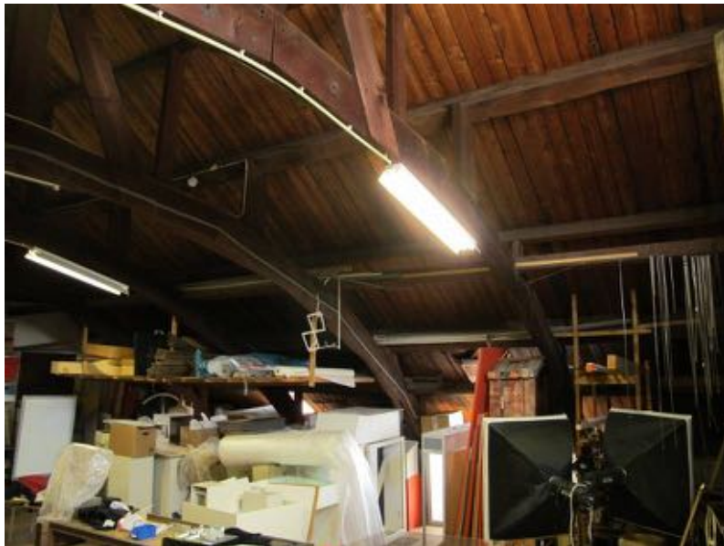
Overzicht kapconstructie met schenkelspanten boven de achterste zolderruimte
