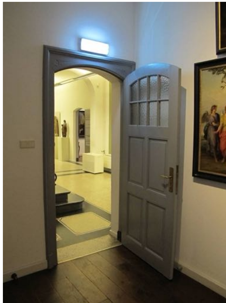
Deurkozijn en paneeldeur uit 1912 in de voorwand van ruimte 0.10
