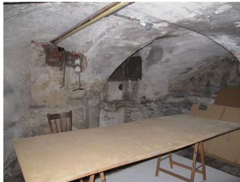
Het bij de voorgevel toegepaste halfgewelf, dat aansluit op de kop van het hoofdgewelf.
