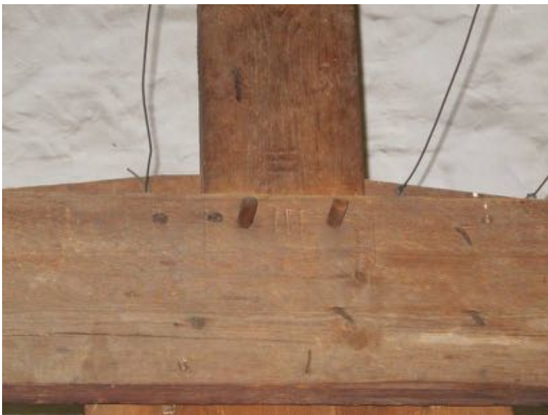
Gehakte telmerken (III) op een spant boven ruimte 2.04
