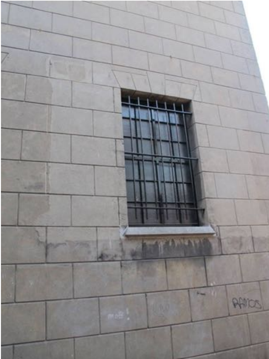
Lichtere aftekeningen van de eerdere vensters aan weerszijden van het huidige venster
