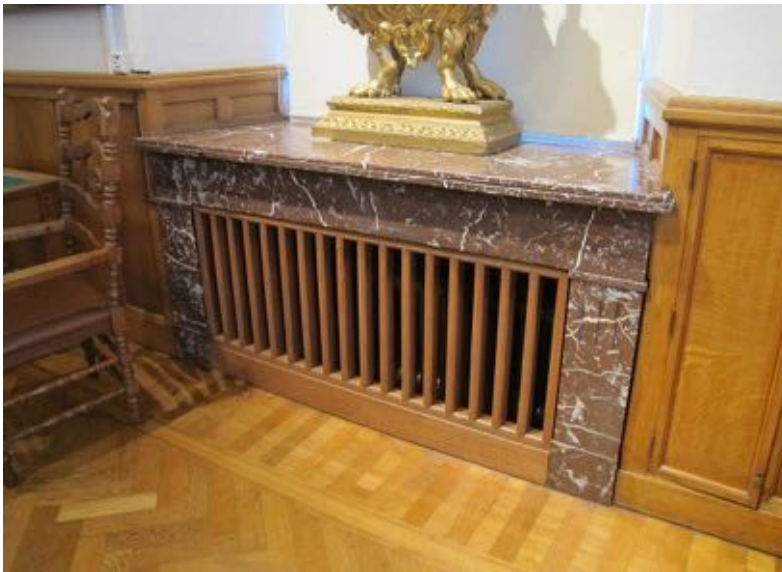
In de lambriseringen opgenomen radiatoromkastingen met marmeren omlijsting en vensterbank
