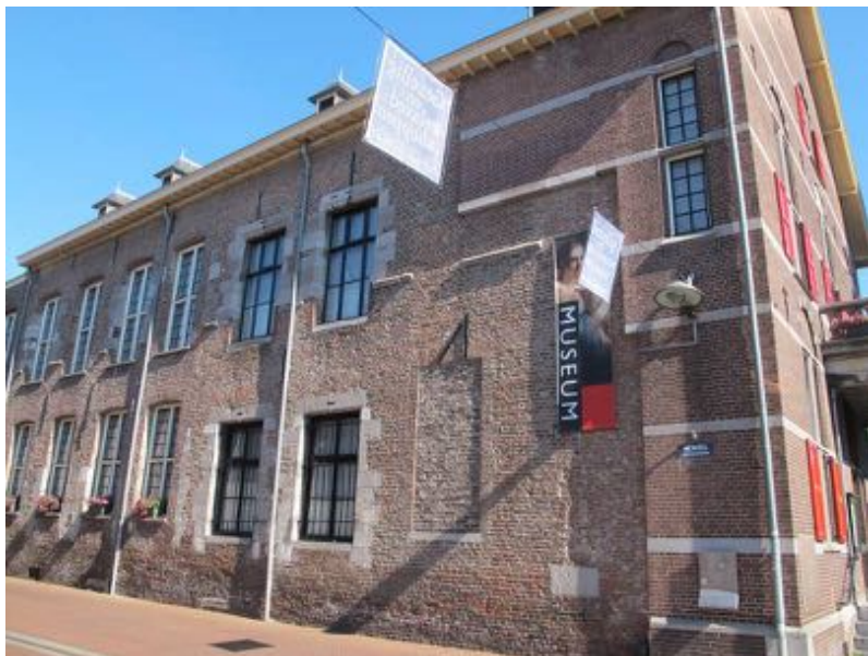
Overzicht van de huidige verschijningsvorm van de linker zijgevel.
