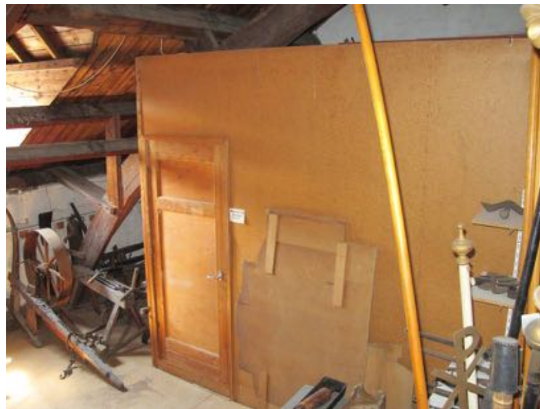
Eenvoudige houten wanden rond de vlaggenopslag (2.07)
