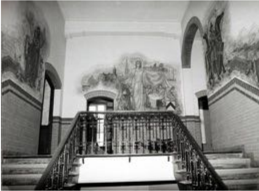
Zicht op de overloop vanaf het trapbordes in 1982. Bron: Collectie Gemeente Weert
