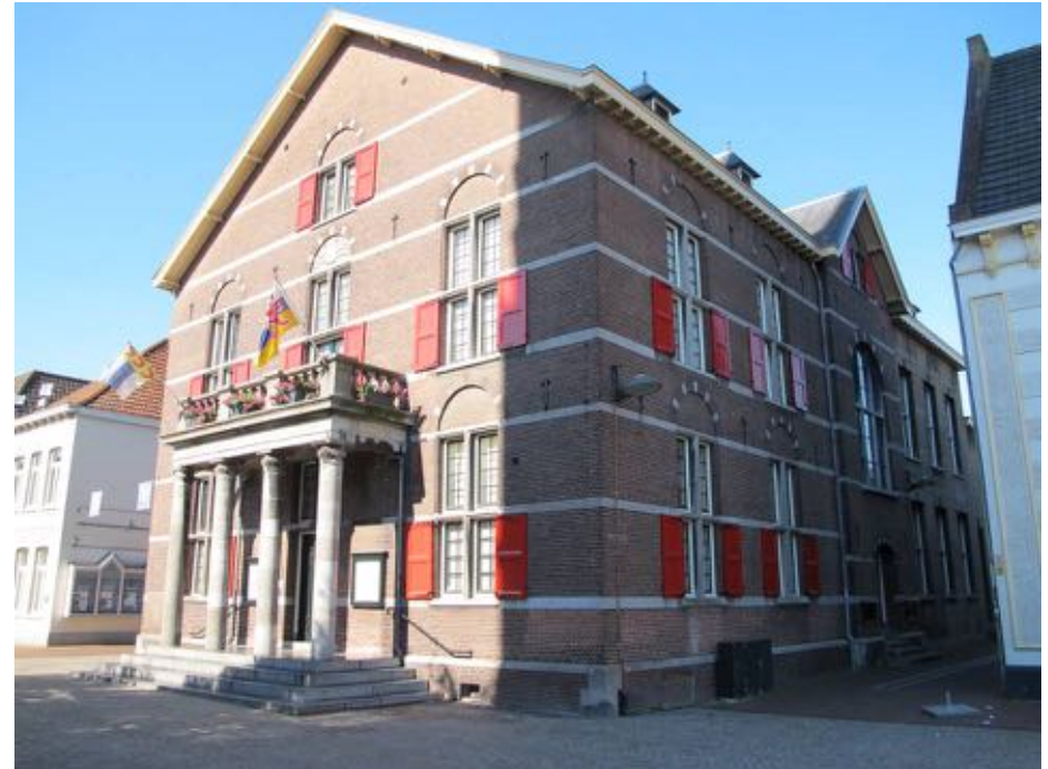
Overzicht van de voorgevel
