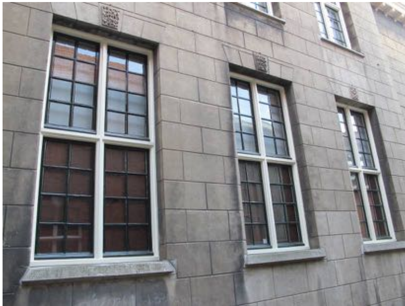
Detail van de vensters in het gepleisterde rechter geveldeel
