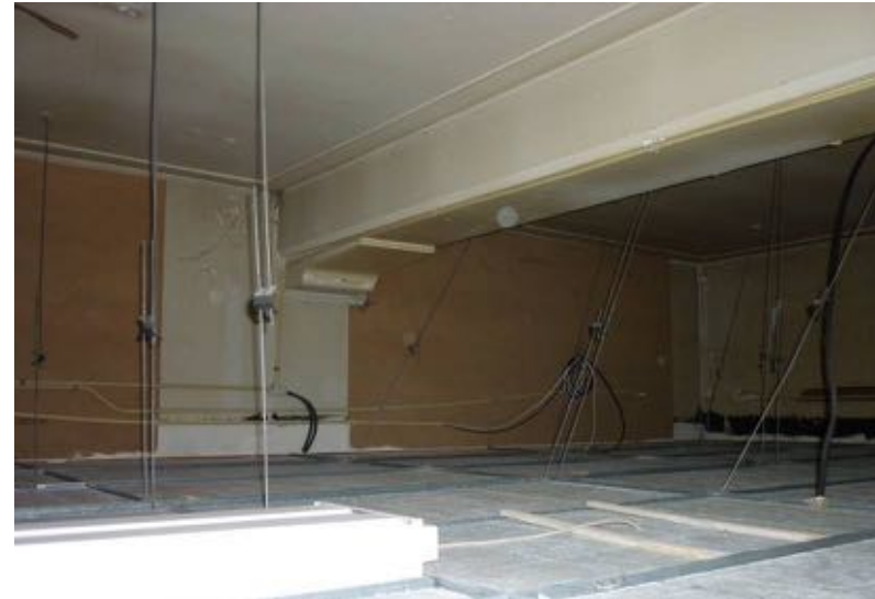
Detail van één van de omstucte balken onder het plafond boven ruimte 1.05. Bron: Collectie Gemeente Weert
