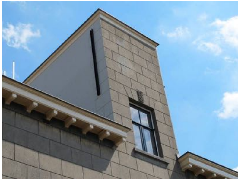
Detail hogere trappenhuisopbouw boven de achtergevel
