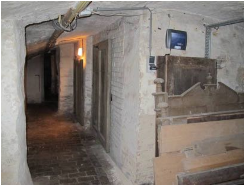
Zicht vanuit achterste linker kelderruimte richting voorgevel
