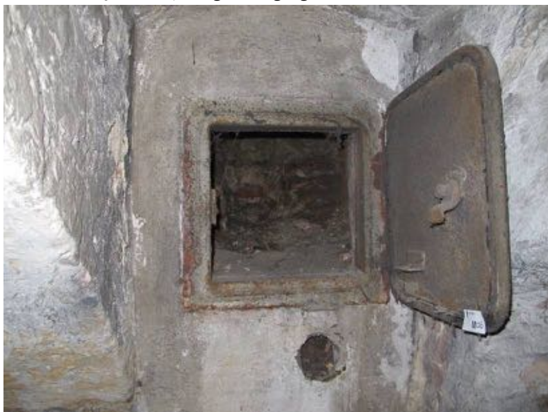
Stalen luik bij opening in voorgevel
