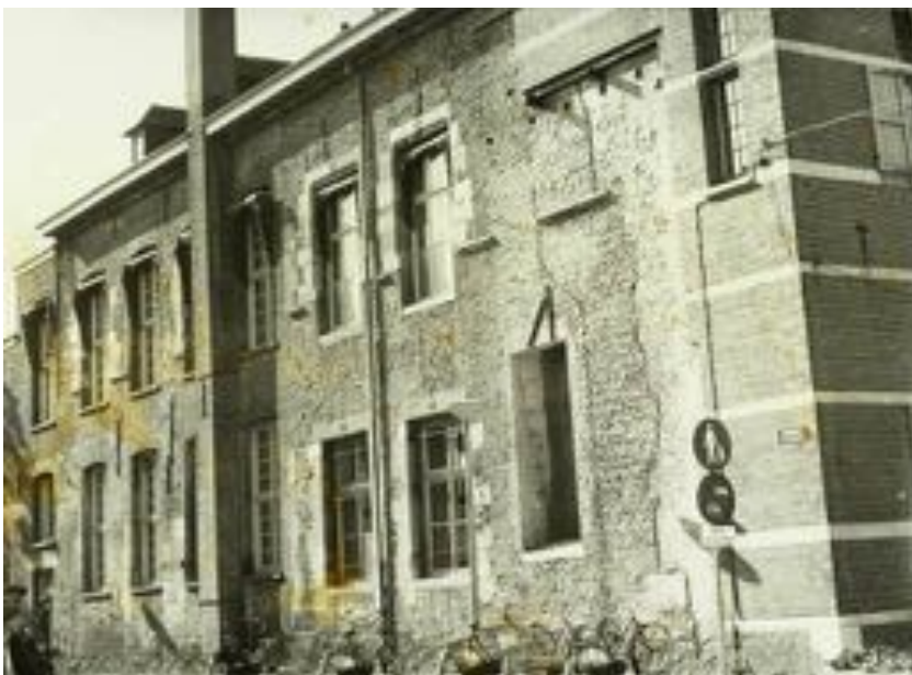
Foto's gemaakt tijdens (boven) en direct na de sloop van het linker buurpand in 1968. Bron: Collectie Gemeente Weert
