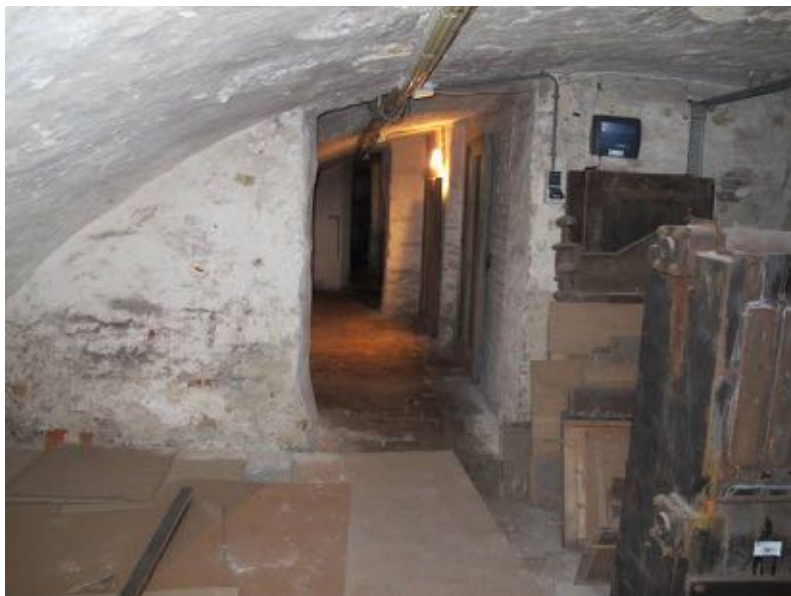
Beeld van de overwelfde opbouw van de linker kelderbeuk, gezien richting voorgevel.
