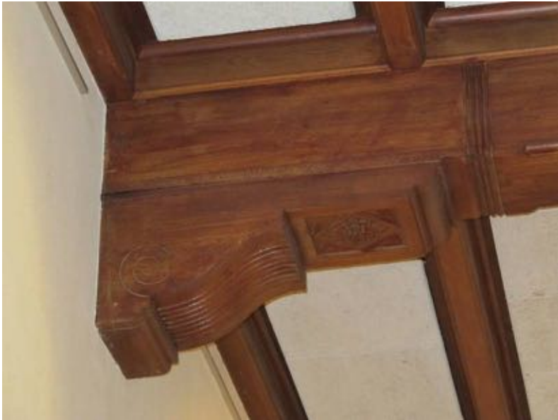
Detail van een console onder de omtimmerde stalen balken boven de raadzaal
