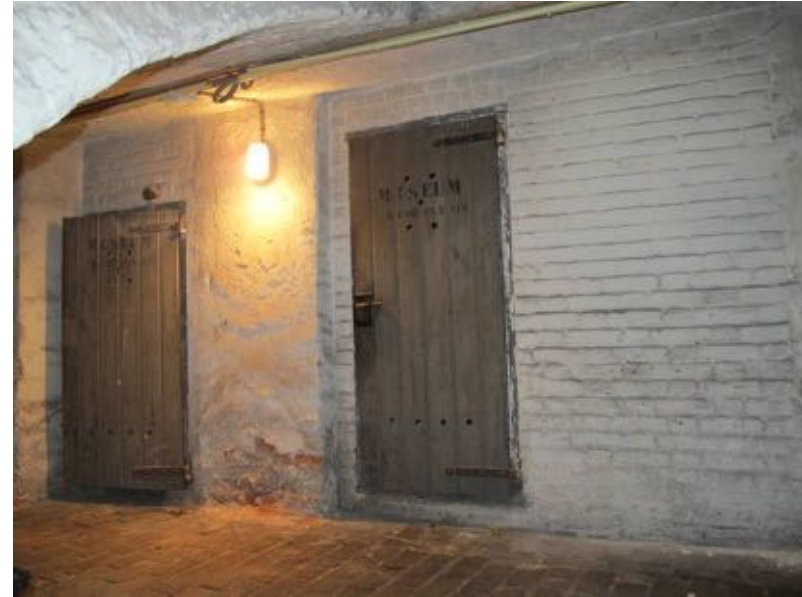
Opslagplaatsen in middendeel linker kelderbeuk
