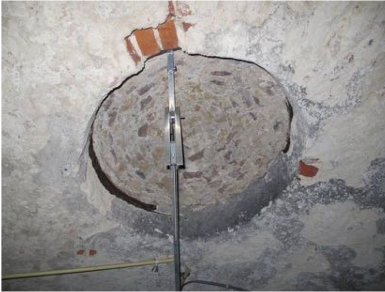
Dichtgemetselde ronde opening in achterste kelderruimte rechts
