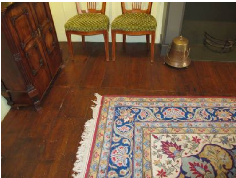
Detail van de historische houten vloer in ruimte 0.02
