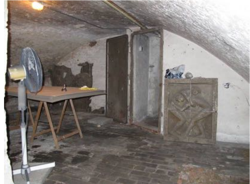
Achterwand van de tweede kelderruimte in de linker beuk met stalen deur
