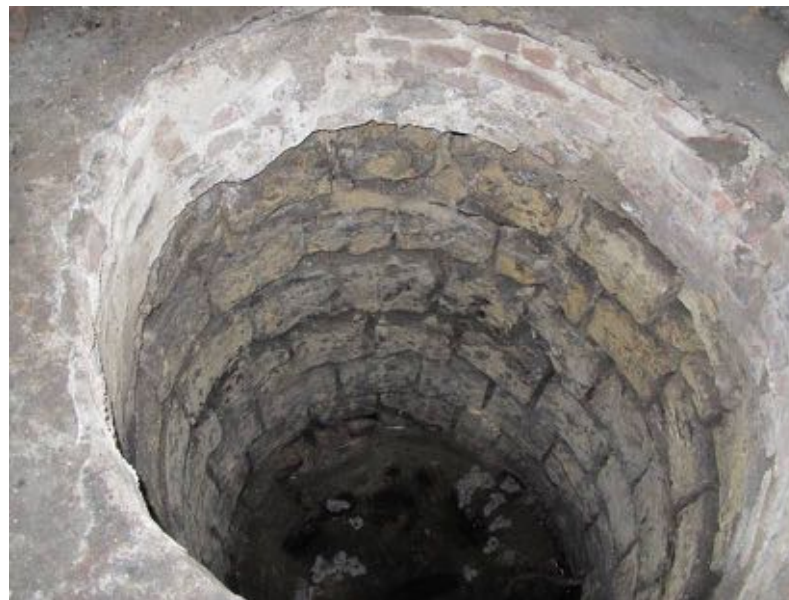
In mergelblokken gemetselde put in linker achterhoek achterste kelderruimte rechts
