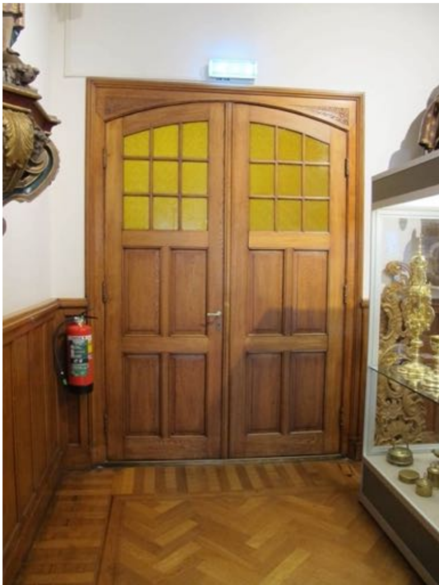
Dubbele paneeldeuren in de achterwand van de raadzaal
