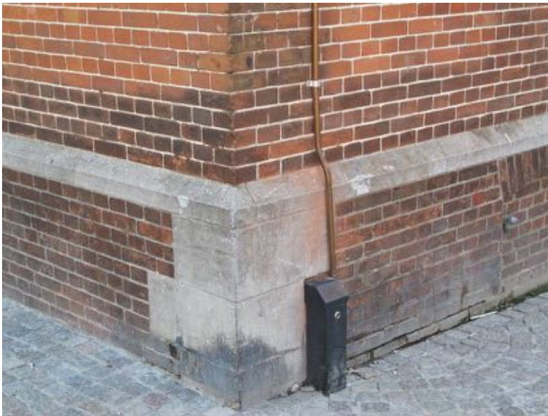
Detail hardstenen hoekblok op rechter voorhoek
