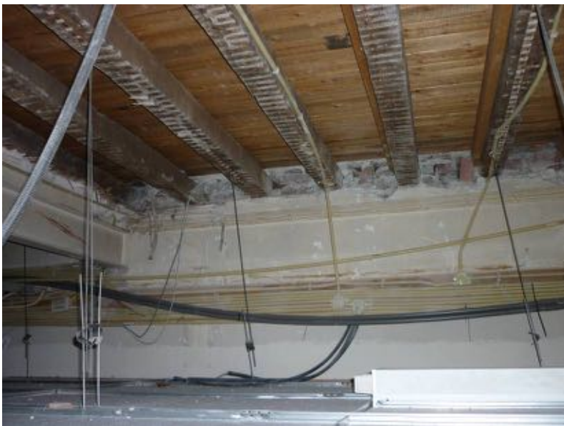
Balklaag boven ruimte 0.05, waar een deels hergebruikte oudere balklaag is gecombineerd met een stalen onderslag (links). Bron: Collectie gemeente Weert
