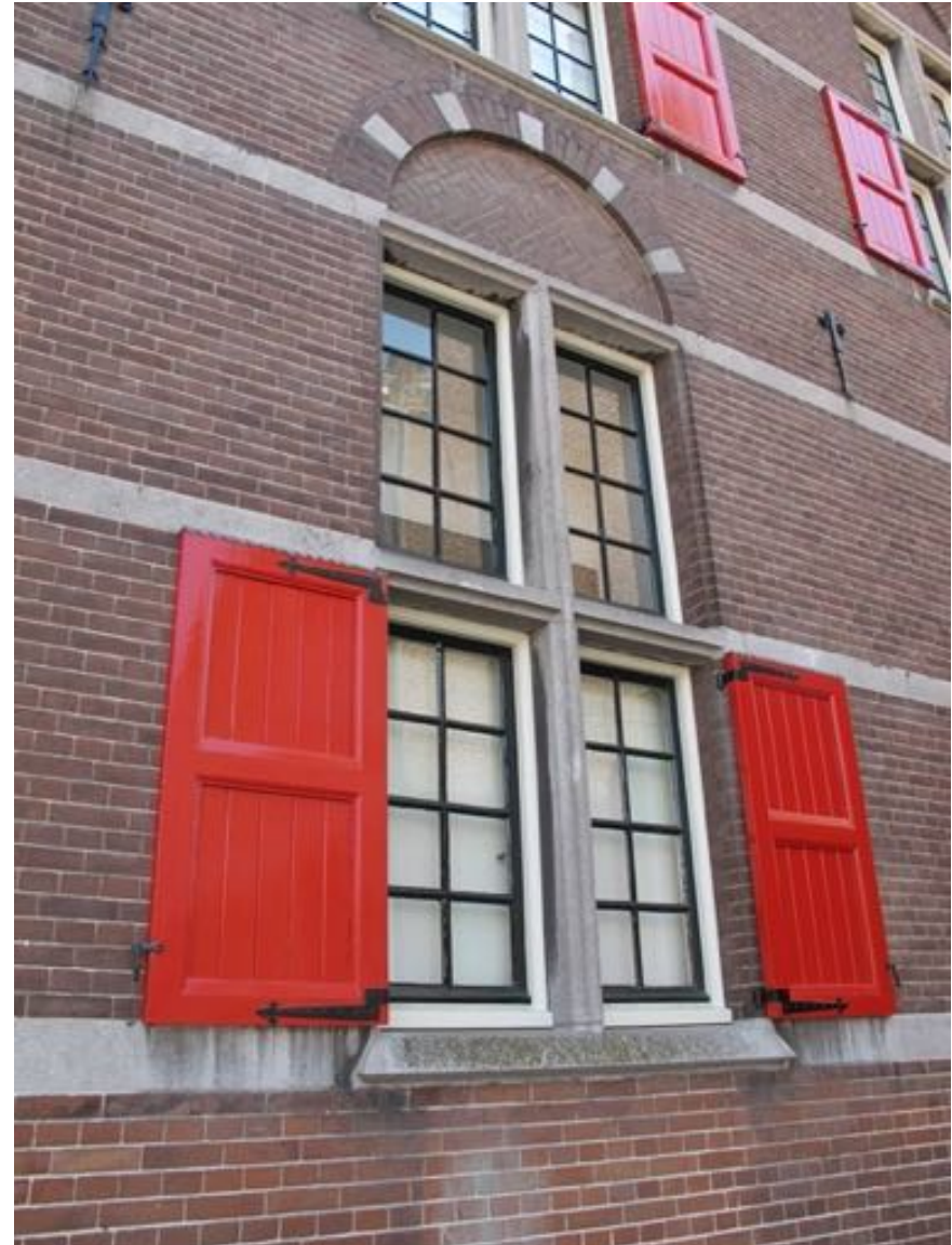
Detail van één van de hardstenen kruiskozijnen in het linker geveldeel
