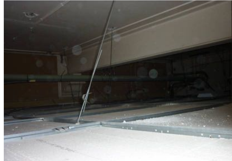
Detail stucplafond boven ruimte 0.09. De stalen balken lagen hier in het zicht. Bron: Collectie gemeente Weert
