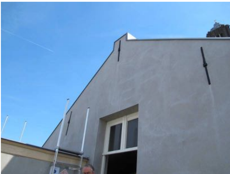
Overzicht bovenste deel topgevel van de gepleisterde achtergevel
